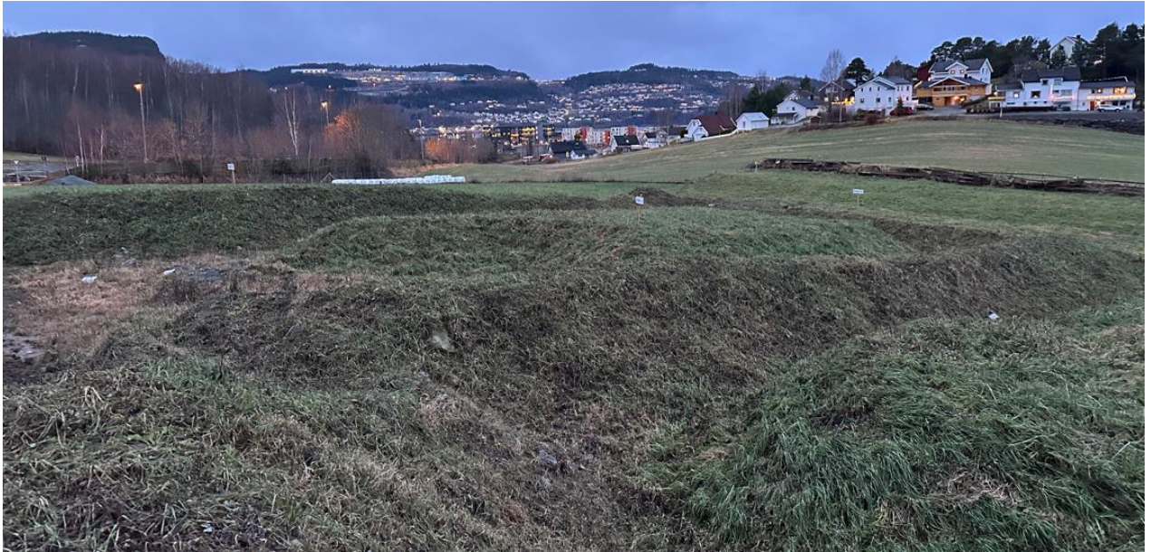
Figur 10 Ranker av mellomlagret matjord ved Hommelvikkrysset, tilsådd med gras, kilde: Rambøll
