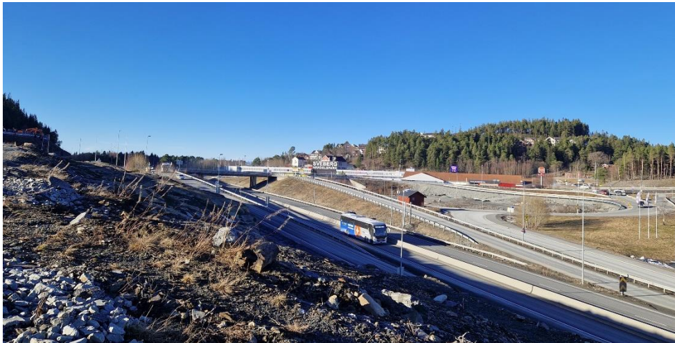
Figur 5-3 Sikt fra sørsiden av E6 mot kolle/boligområde i nord
