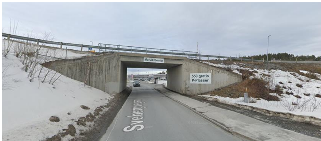
Figur 6-5 Dagens kulvert for føring av Svebergveien under Stavsjøvegen. Kilde: Google Maps
