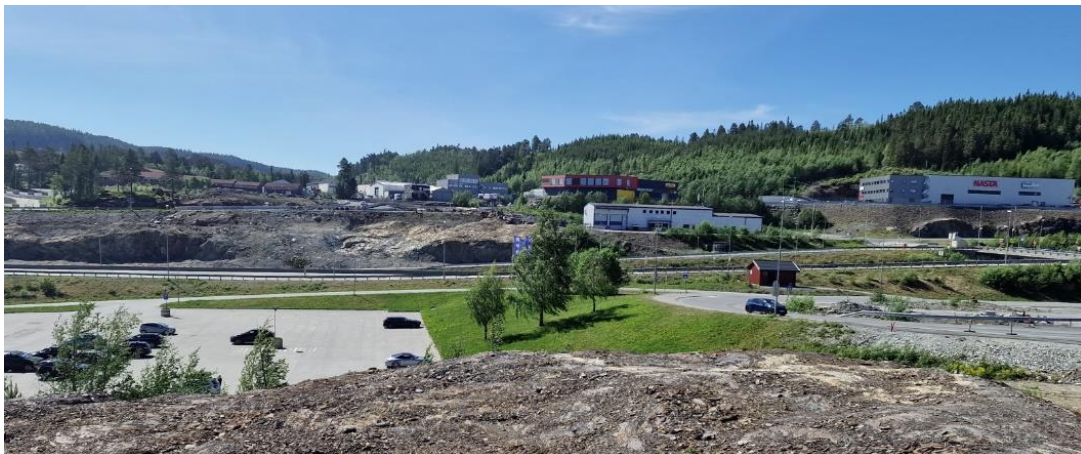
Figur 5-2 Svebergkrysset/E6 sett fra nord
