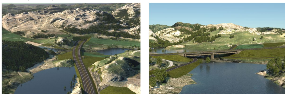
Figur 6-17: Venstre: Nærføring Polltjøna, kryssing av Kjedlandsåna og tunnelinnløp i sør. Hadvardshølen ligger øst for tunnelmunningen. Det er avsatt areal til riggområde til venstre for tunnelen. Høyre: Bro med søyle i elv, sett mot øst.
