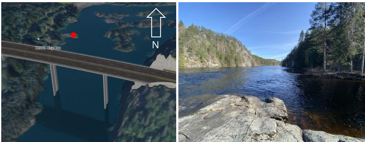
Figur 6-30: Tisjø bru sett fra sør. Foto viser Tisjø sett fra vestre bredd (rødt punkt) og sørover mot punkt for brukryssing (Sweco Norge)
