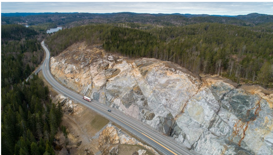
Fjellskjæring ved Dørdal, bak ligger Bakkevann (Bamble) og Hullvann (Kragerø) Foto: Dronefoto: Per-Kåre Sandbakk / NRK
