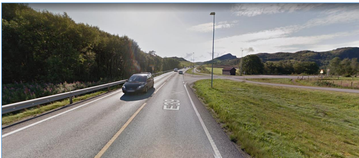
Figur 15: Ved Bollestad, E39/fv. 4410 Sikvalandsvegen (Google maps, 2020).
