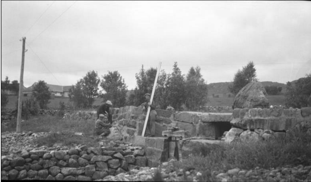
Figur 5-6: Reguleringsdam ved Ytra Kydlandsvatnet. Fotografiet er datert til 1934. Kilde: Digitaltmuseum.no.
