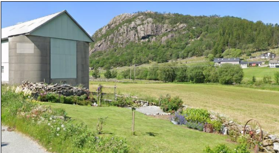
Figur 6-35: Ruin ved Krekebærholen. På tunet stod det tidligere et eldre våningshus og en løe, oppført i 1885. Løa ble revet i 1960-årene, og våningshuset i 1978. Kilde: Google Maps, 2019.
