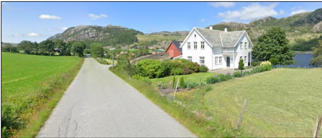
Figur 6-37: Tidligere Kyllingstad skole. Bygget framstår godt vedlikeholdt. Bygget er oppført ca. 1900, og er inspirert av sveitserstilen. Kilde: Google Maps, 2019.
