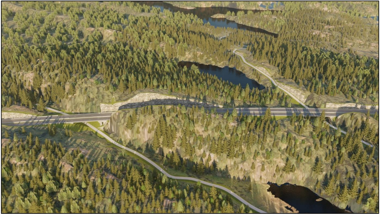
Figur 3-25 K268 Lonetona faunapassasje vest og K267 Lonetona faunapassasje øst, sett fra sørvest.
