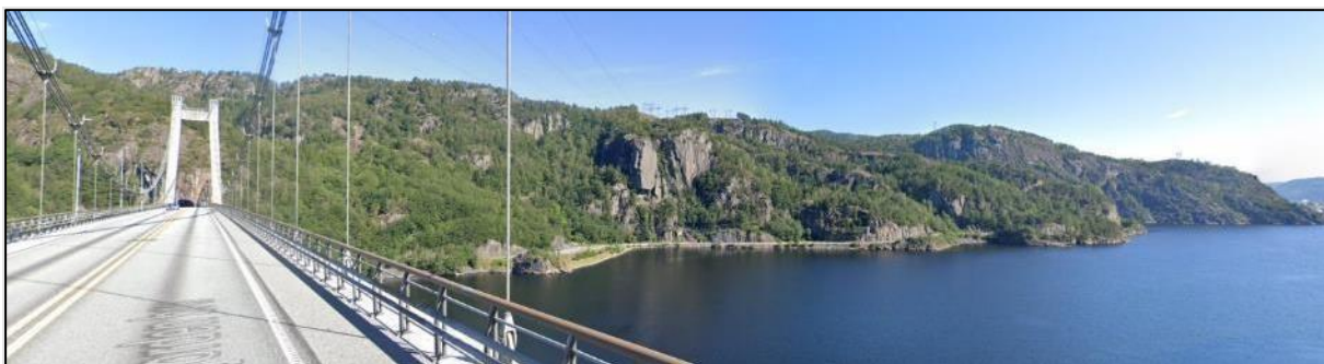
Figur 2-3 Fra Fedafjorden bru. Angholmveien med Hangelandsspeilen og Raustad.
