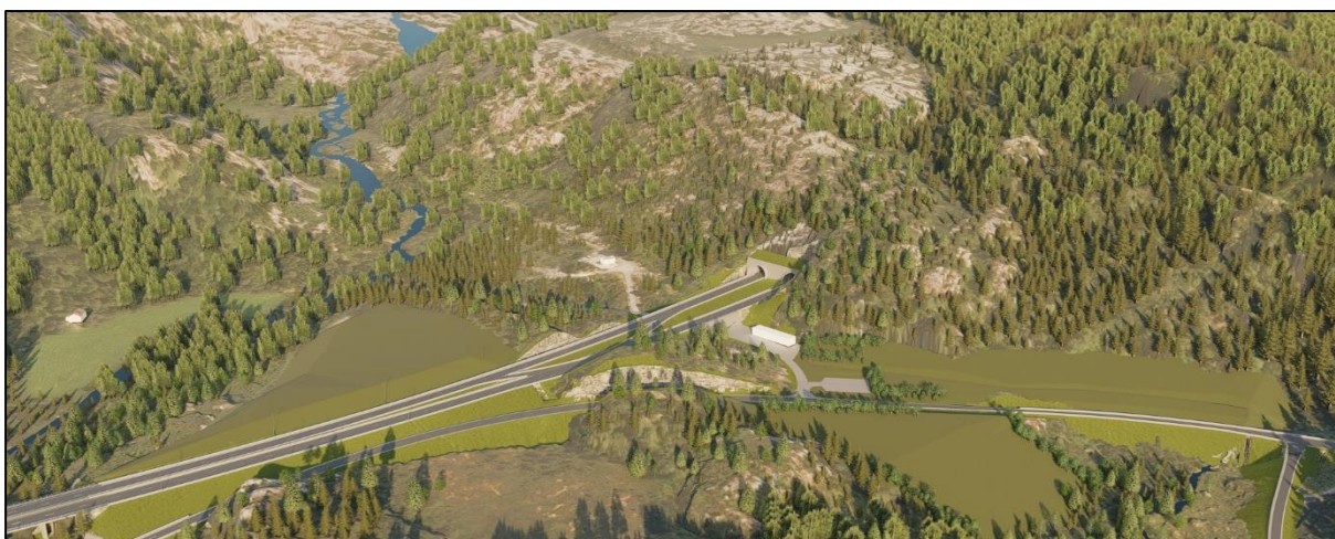
Figur 3-6 Masselager ved Avkom.
