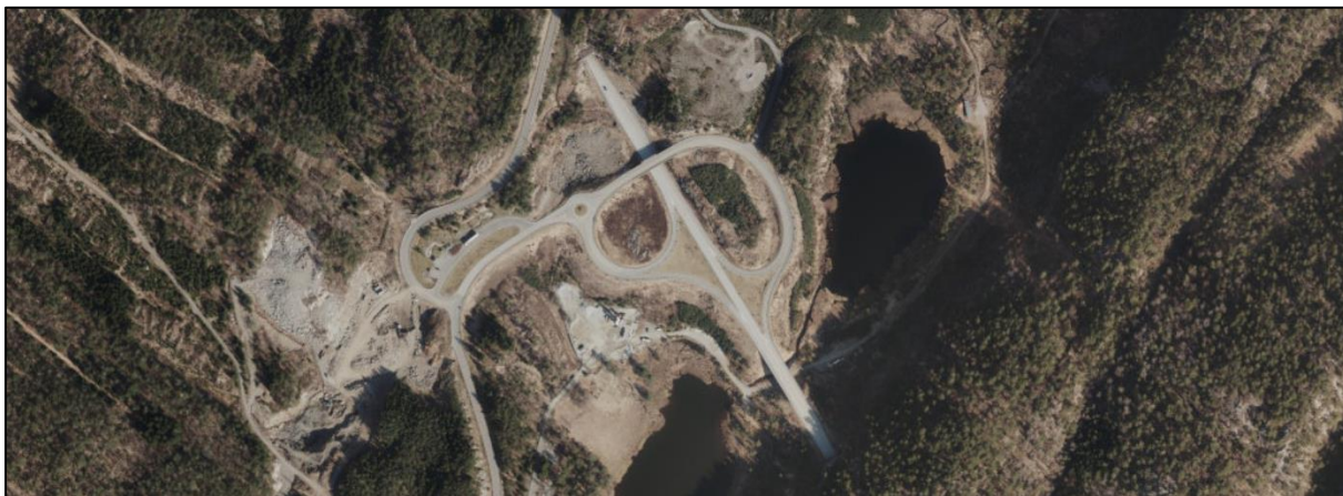
Figur 2-2 Oppofte med dagens E39-kryss, Lister næringspark, Ytretjønn og Indretjønn.
