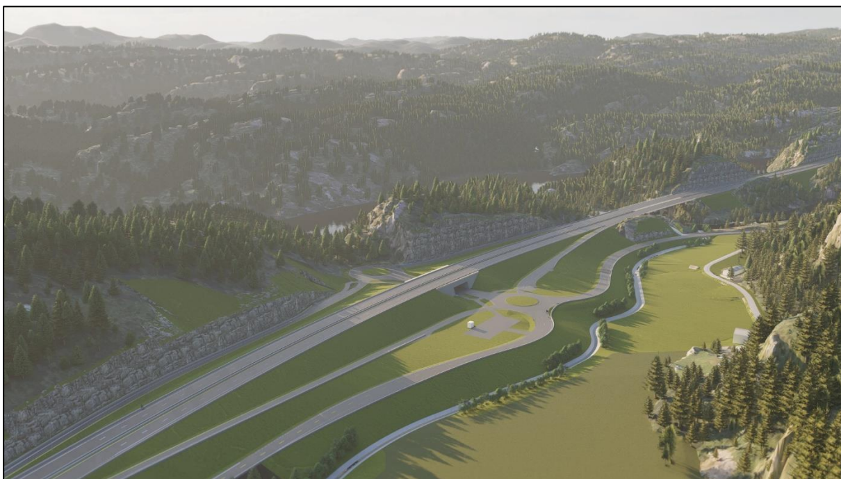
Figur 3-22 K250 Frøyland-krysset sett fra sørøst.
