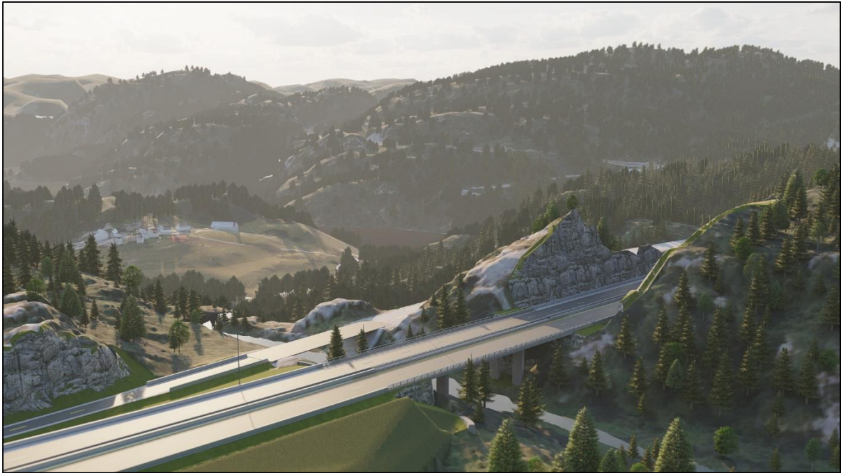
Figur 3-19 K180 Ny Storfossen bru sett fra øst.
