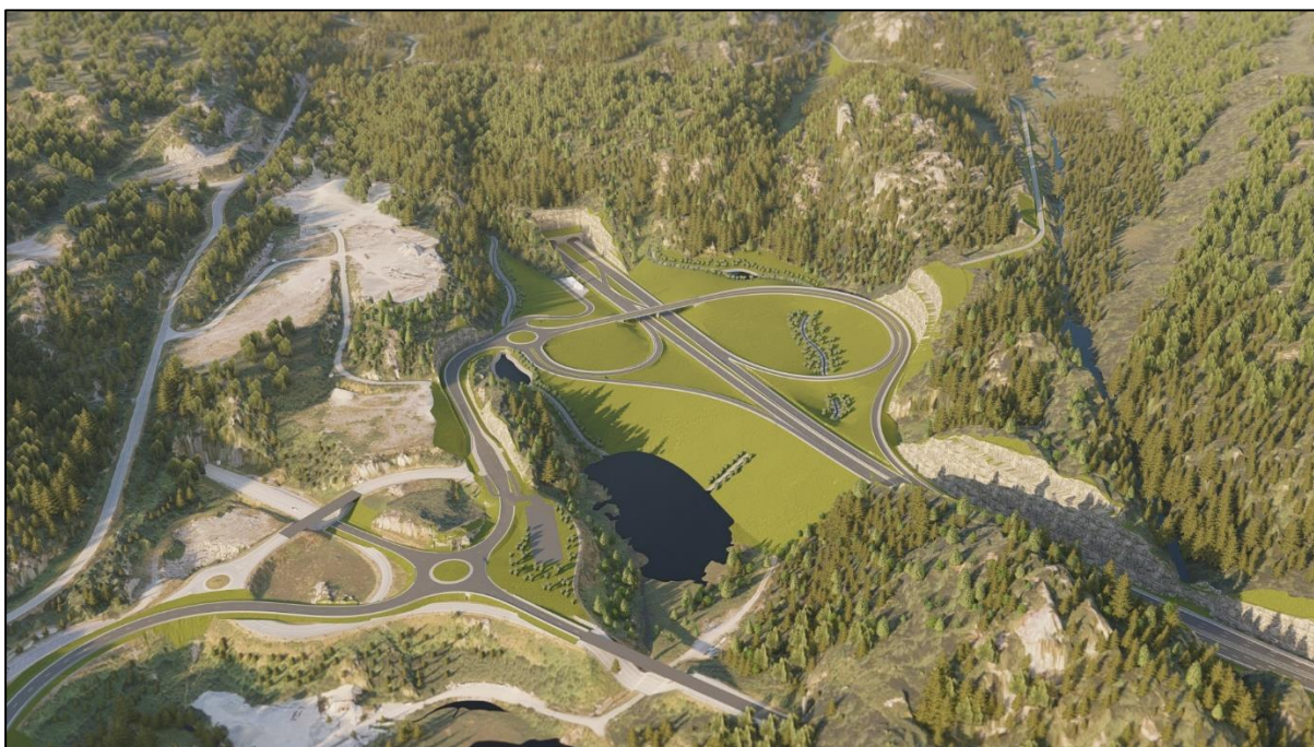
Figur 3-7 Krysset ligger på høye fyllinger som delvis går ut i Indretjønn.
