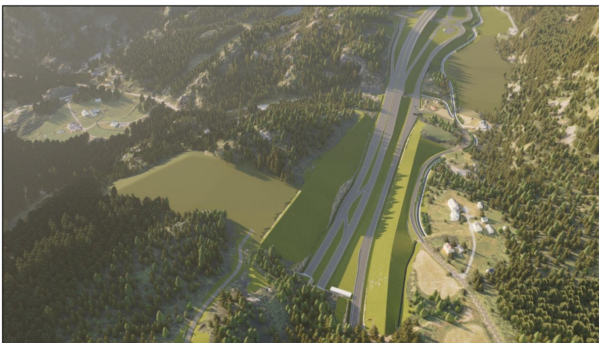
Figur 3-36 Viser masselager Frøytland Sør.
