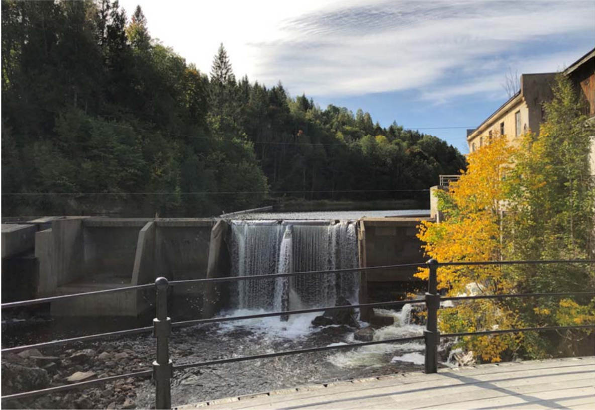
Figur 6-37 Fossstveit-demningen sett fra brua ved kraftstasjonen. (foto: COWI AS)
