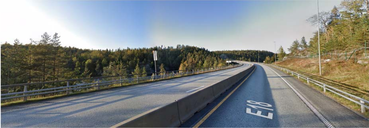
Figur 6-26 Eksisterende E18 ved Pinesund. (Google maps Streetview)
