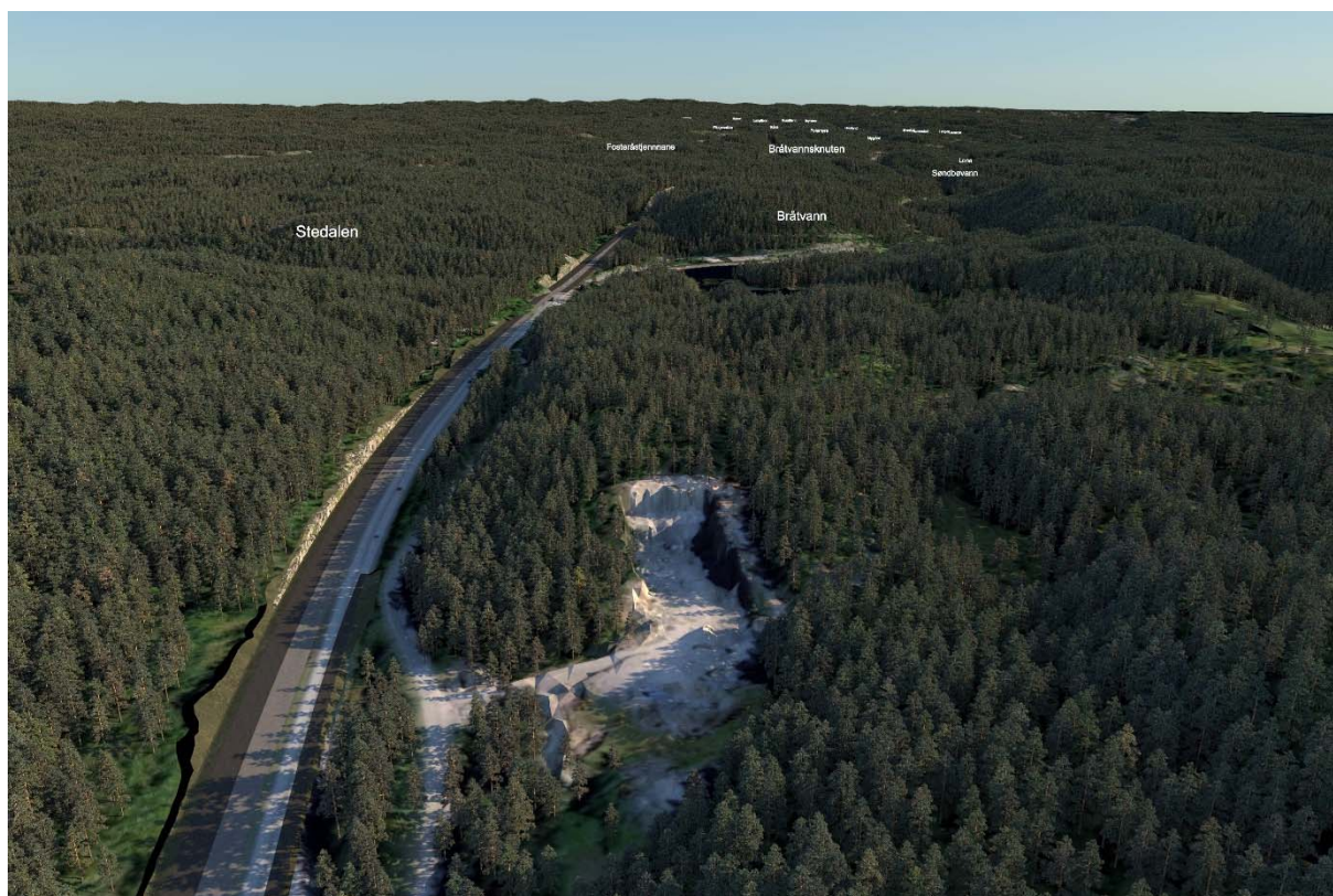
Figur 6-18. Ny E18 over Slettefjell. Lona helt til høyre i bildet og Plasstjenn til venstre. (Cowi AS, 2021)
