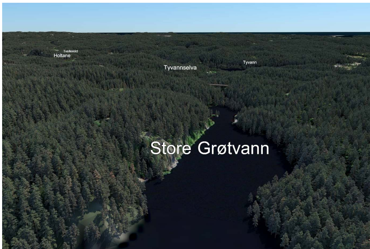
Figur 6-13 Ny E18 i bru over Tyvannselva, sett fra Store Grøtvann.
