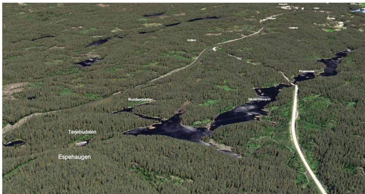
Figur 6-28 Oversiktsbilde Molandsvann med ny E18 til venstre i bildet, og eksisterende E18 til høyre. Eksisterende E18 til høyre i bildet skal tilbakeføres til naturlandskap så langt det er mulig.
