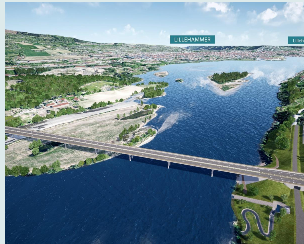
Ny bru over Lågen. Illustrasjon Nye Veier
