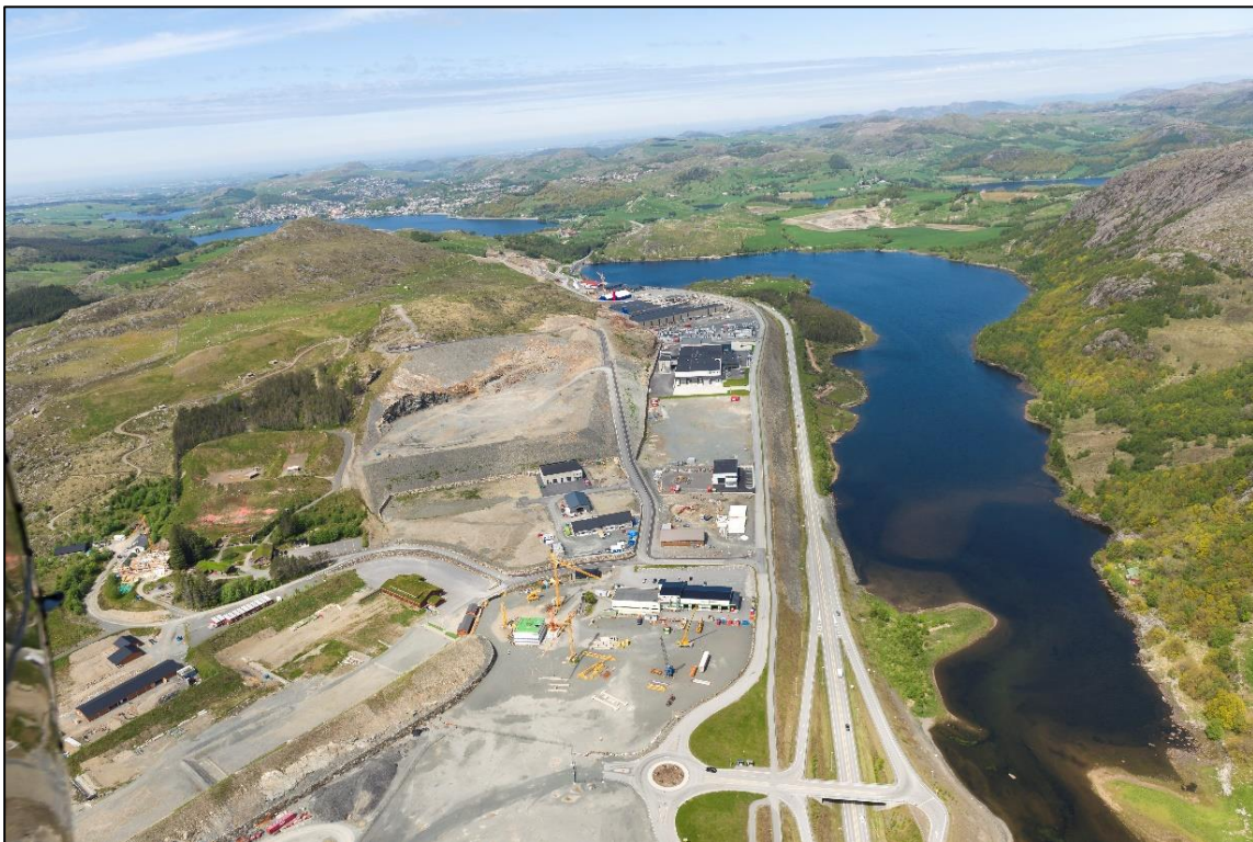
Figur 6-21: Eksisterende E39 forbi Klugsvatnet sett fra sør. Foto: Statens vegvesen.
