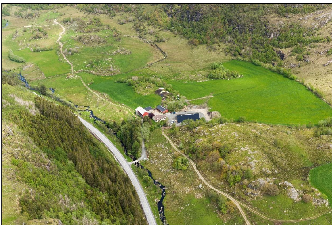
Figur 6-9: Eksisterende E39 og Oppsalåna ved Gautedal sett fra sør. Foto: Statens vegvesen
