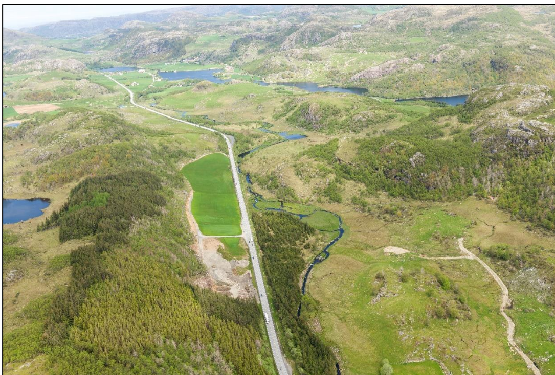
Figur 6-10: Eksisterende E39 og Oppsalåna i Søylandsdalen sett fra sør. Foto: Statens vegvesen.
