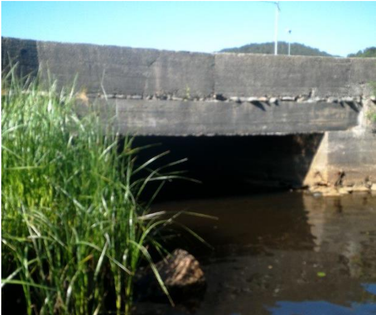
Figur 8-1: Innløp av eksisterende kulvert/bru under fv. 465 Øyesletta.
