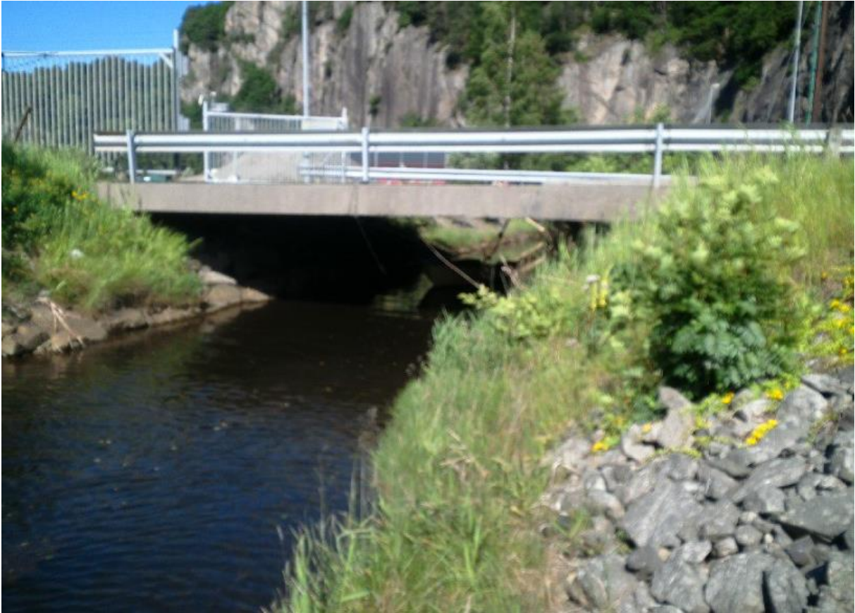
Figur 8-4: Bru til kaianlegg over Kleivsbekken på Øyesletta. Sett fra oppstrøms side.
