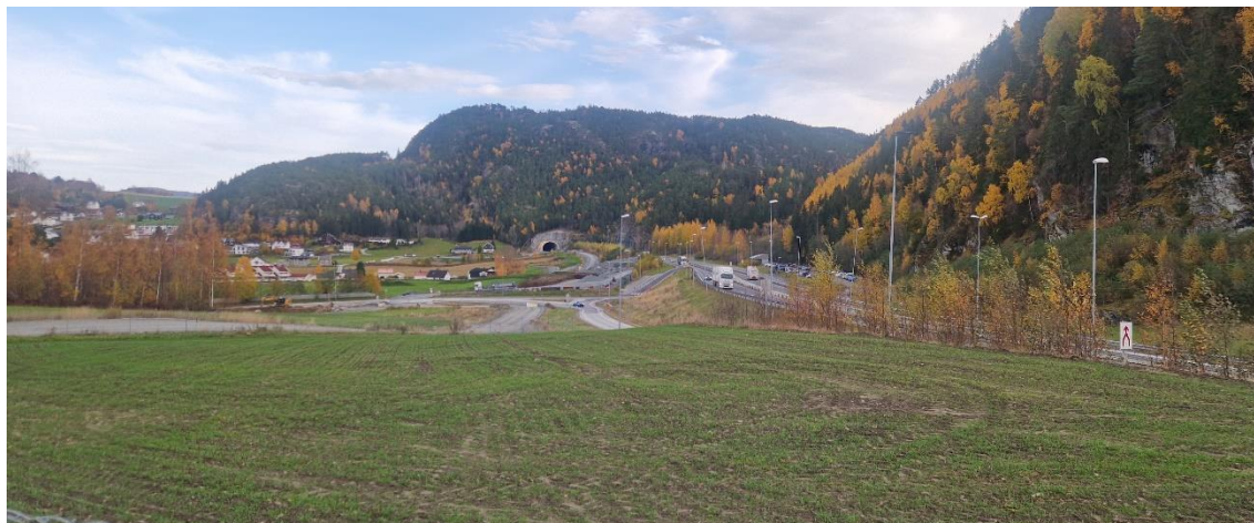
Figur 5-2 Bilde i retning mot Hommelvikkrisset og Helltunnelen.
