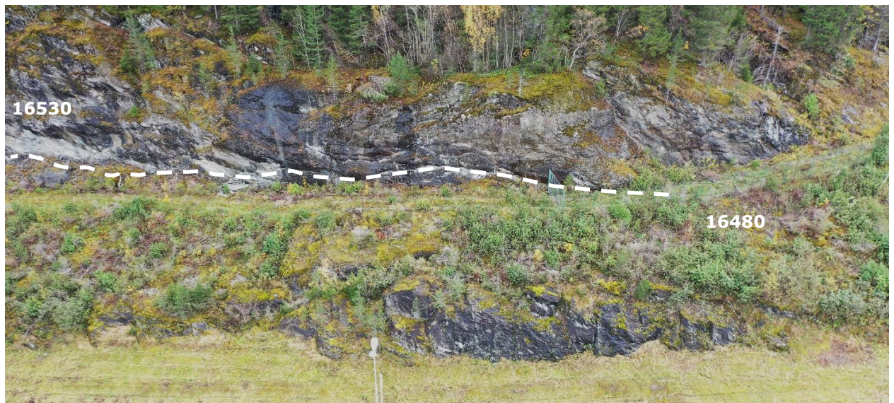
Figur 29: Dronebilde av svakhetssone 2 langs eksisterende avkjøringsrampe.
