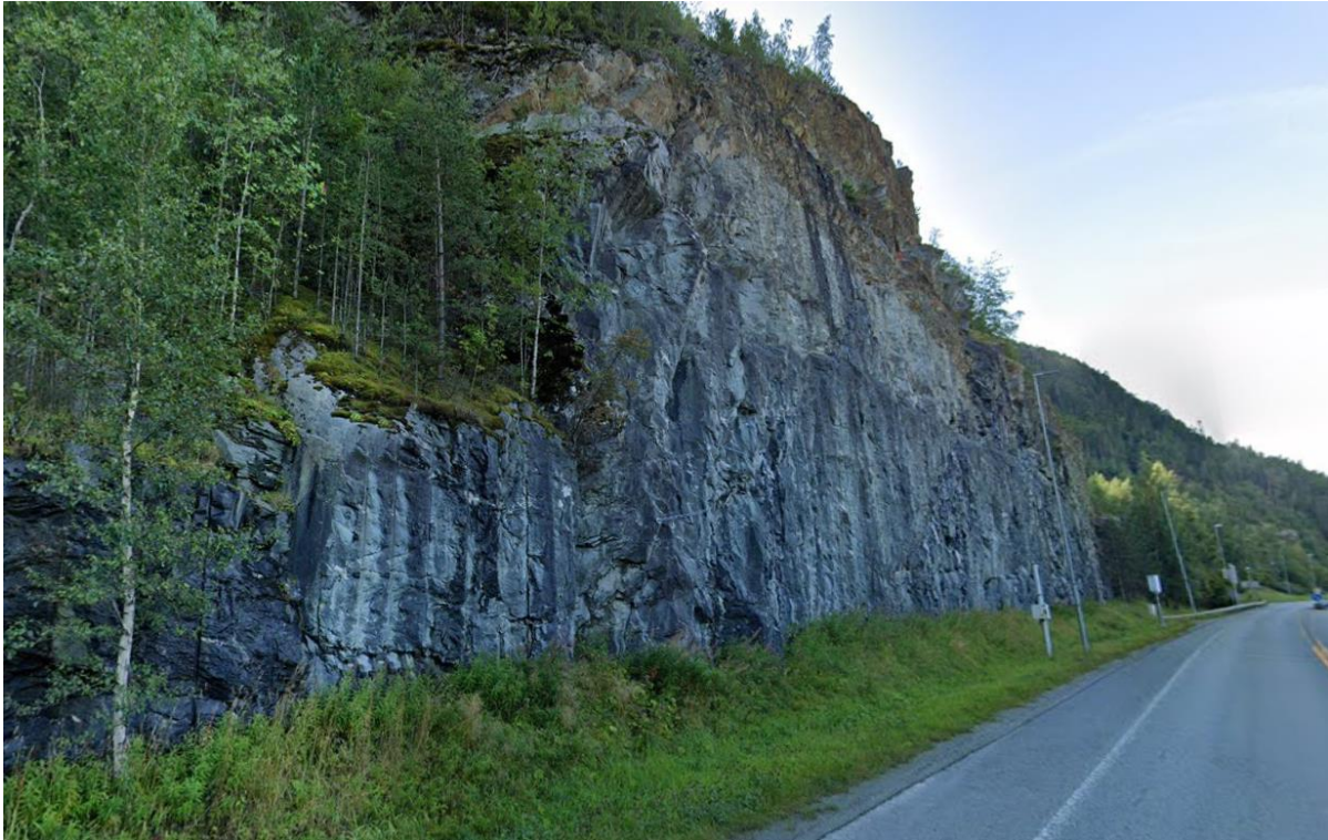
Figur 7: Eksisterende bergskjæring i nærheten av vestlig påhuggområde til Helltunnelen, fra profilnr. 17030-17130. Bildet er tatt mot sør.
