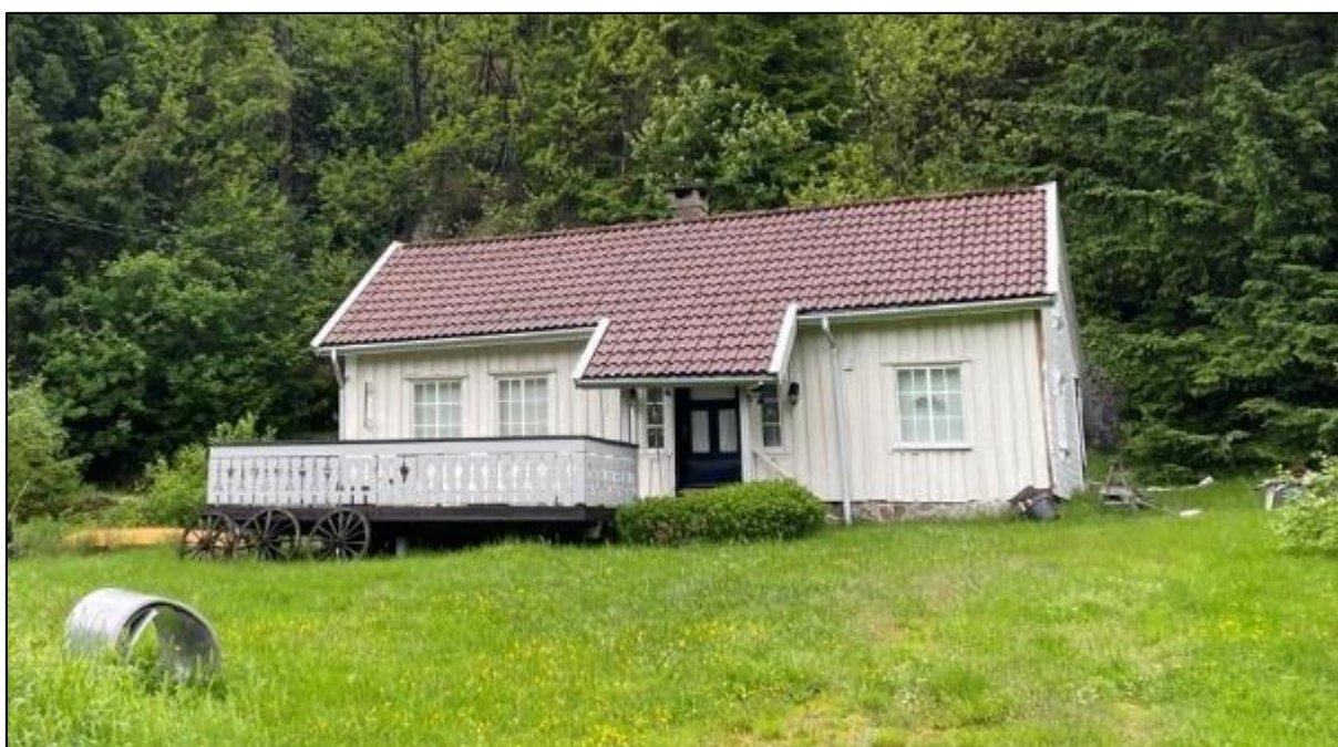
Figur 7-98: Våningshuset på bnr. 2 (SEFRAK 1037-0016-023) ble trolig bygd en gang mot slutten av 1700-tallet. Foto: Monika Serafinska, Sweco.
