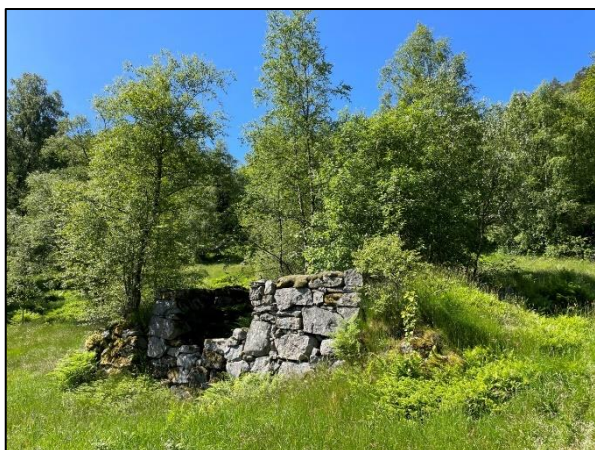
Figur 7-140: Tuft 1 (SEFRAK 1037-0014-074, Askeladden-ID 278809-1), mur etter løe på bnr. 2, sett mot sørvest. Foto: Monika Serafinska, Sweco.
