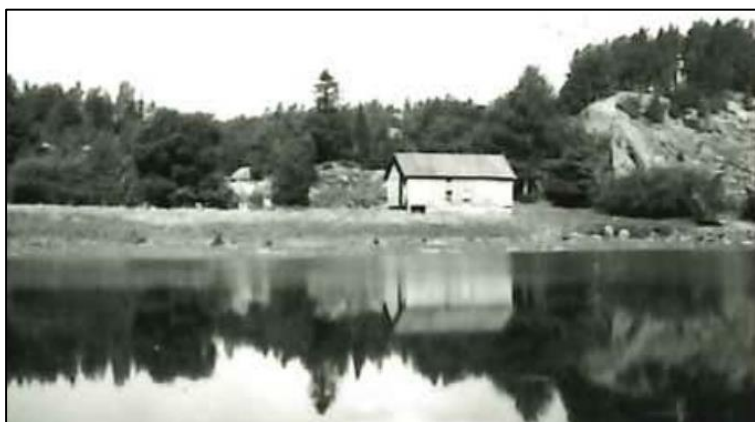
Figur 7-209: Løa på Frøitlandsnes (SEFRAK 1037-0014-023). Fotografert til SEFRAK-registreringen i 1982.
