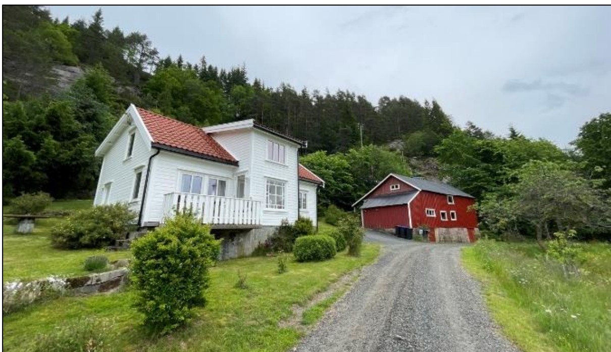
Figur 7-8: Våningshuset på Åtland, bnr, 2, ble trolig satt opp en gang rundt 1850 (SEFRAK 1032-0004-022). Foto: Monika Serafinska, Sweco.
