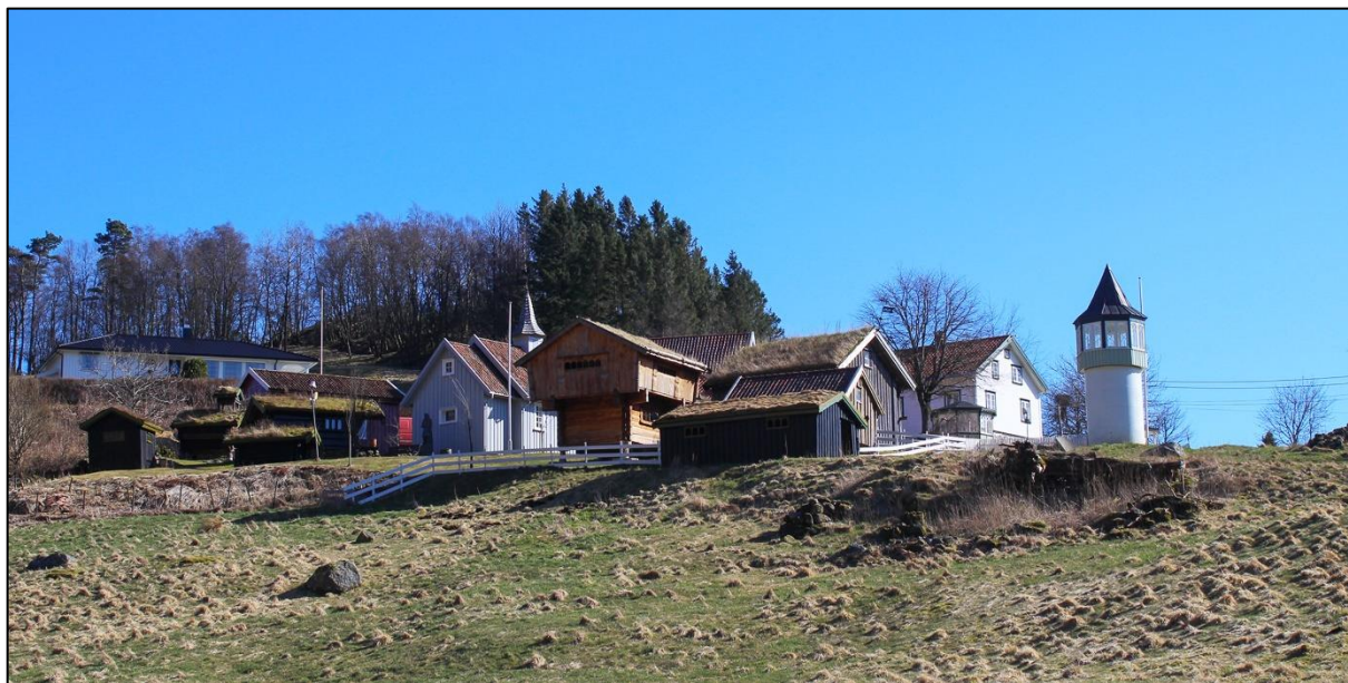
Figur 7-212: Gårdstunet på gnr. 112/6 består av flere interessante byggverk. Foto: Jan Adriansen, Sweco.
