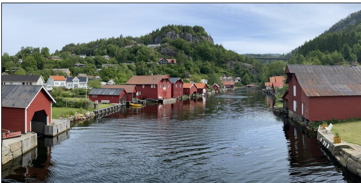
Figur 7-165: Oversiktsbilde over eldre naustmiljø i Feda, nordøst for brua over Fedaelva. Foto: Monika Serafinska, Sweco.
