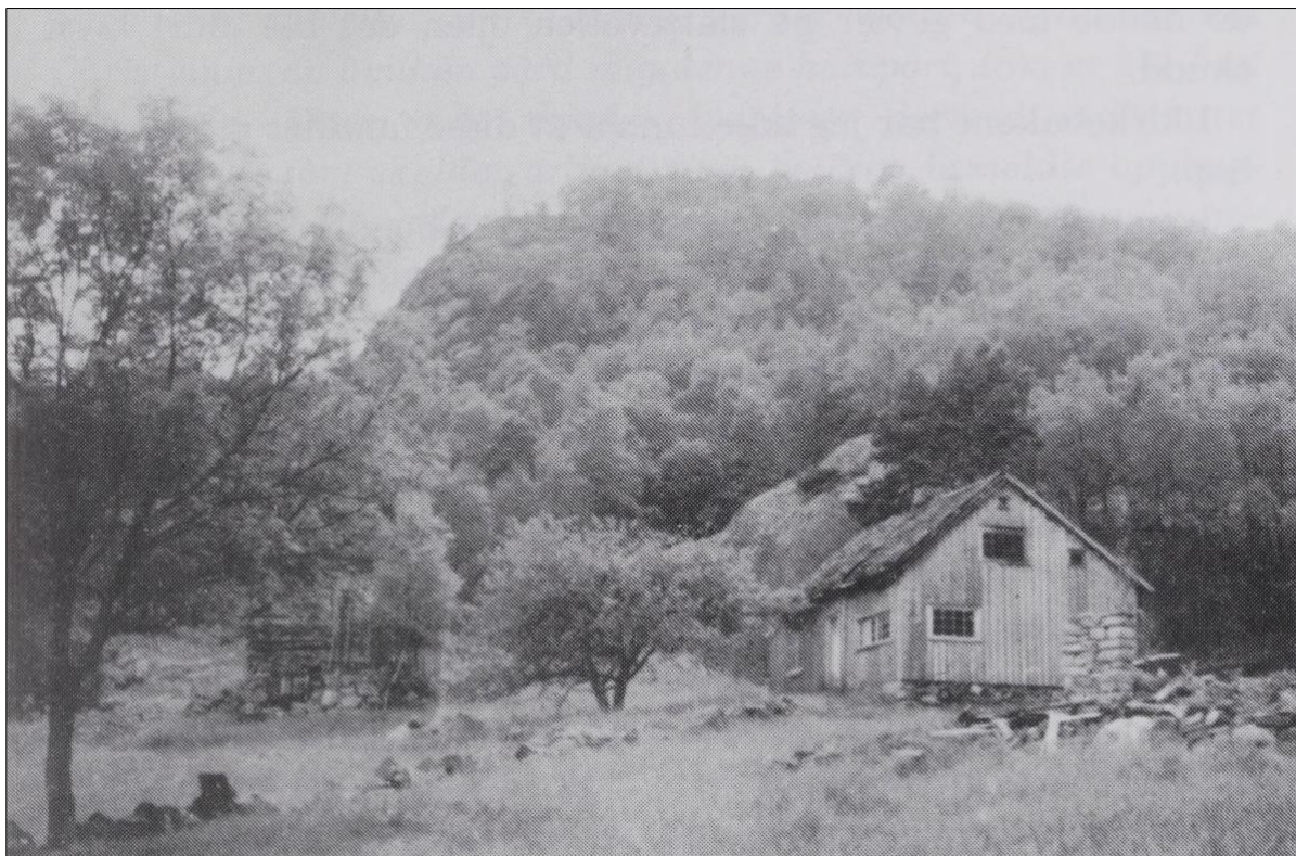
Figur 7-145: Hangeland mens husene fremdeles stod i 1976. Ukjent fotograf. Kilde: Årli, 1980, s. 145.
