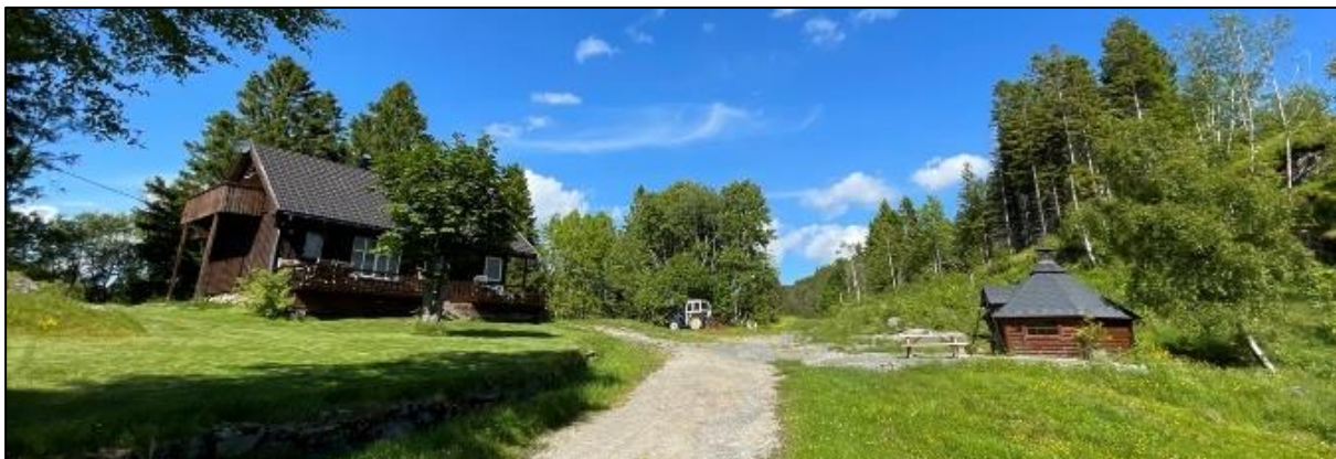
Figur 7-106: Tunet på bnr. 3 og 4. Det gamle våningshuset fra 1854 (SEFRAK 1037-0016-032) er i dag erstattet av et nytt hus. Foto: Monika Serafinska, Sweco.
