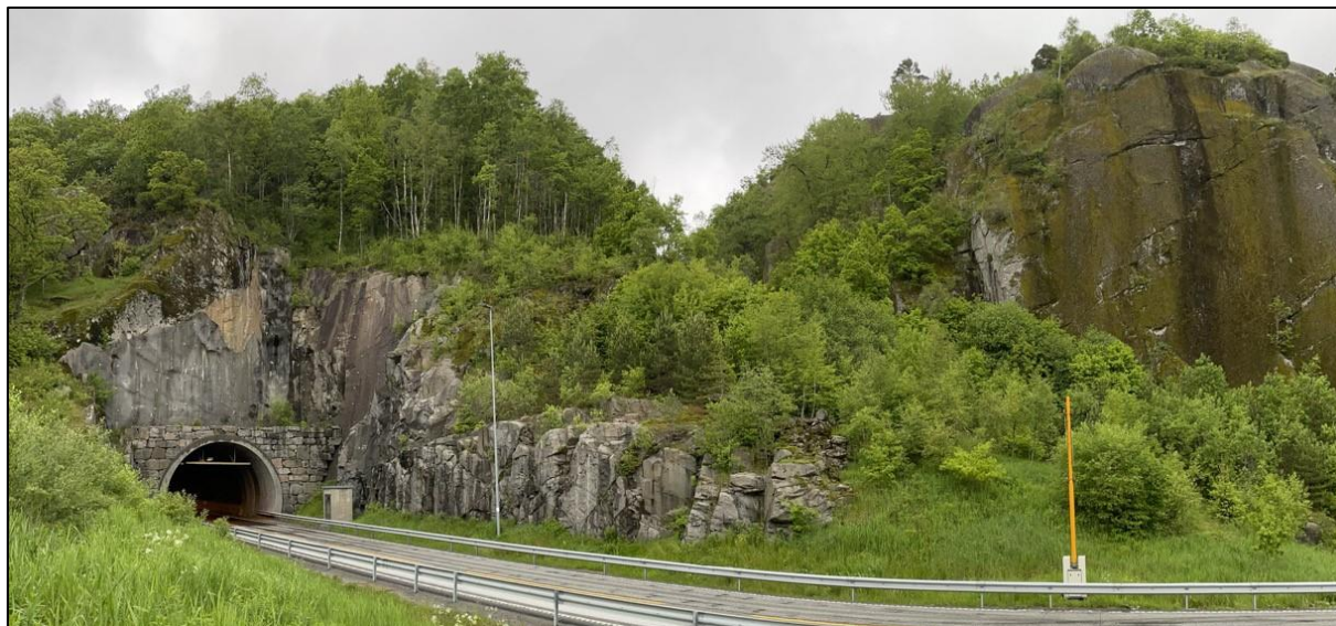
Figur 7-91: Etter utbygging av E39 i 2005 ble bekken på Rørdal lagt i et annet løp og en kvernhusruin (Askeladden-ID 280927) ligger i dag på en berghylle foran portalen til Vatlandstunnelen. Foto: Monika Serafinska, Sweco.
