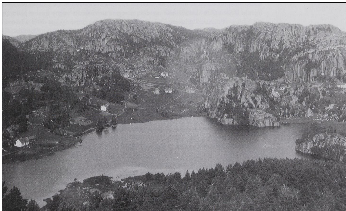
Figur 7-176: Svindland fotografert ca. 1910. Våningshuset på bnr. 6 (SEFRAK 1037-0014- 065) øverst i bildet. Foto: Løyland 1999, s. 89.
