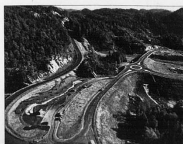
VEIKRØLL: Rasteplassen på Opofte er plassert midt i en stor trafikkmaskin. E 39 sees så vidt under broen like ovenfor rundkjøringen.
