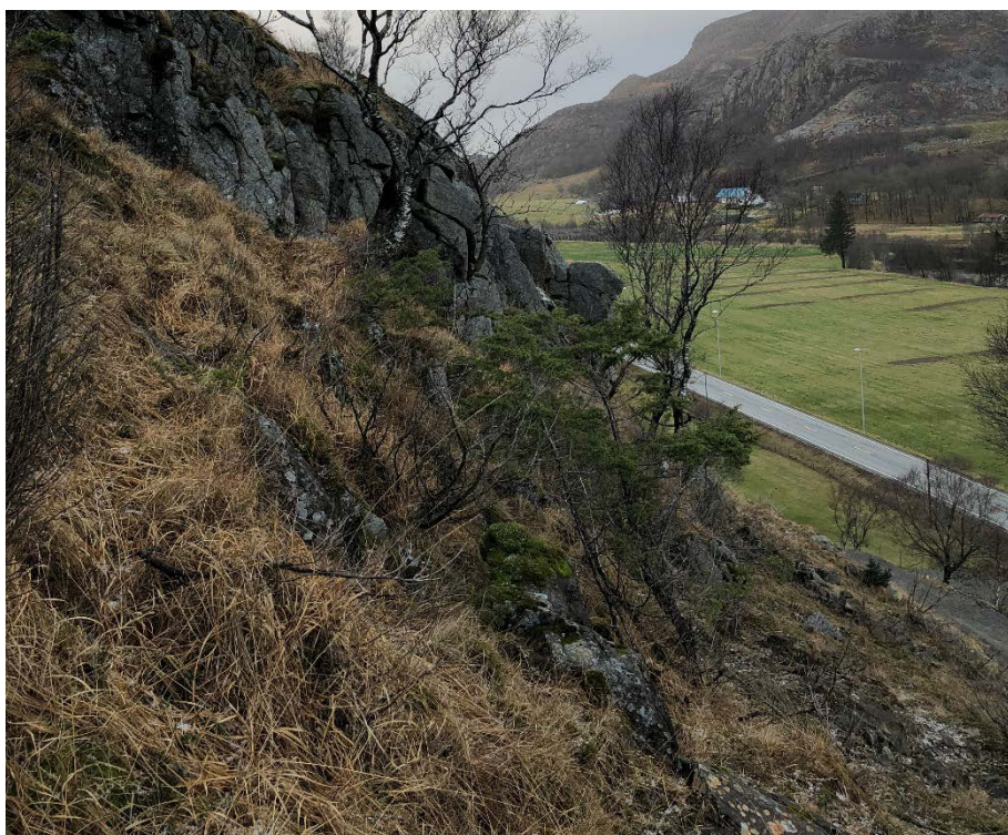
Figur 6-16: Lokalitet S42, bilde mot nord. Det var flere løse blokker i blotningen ved skjæringen.
