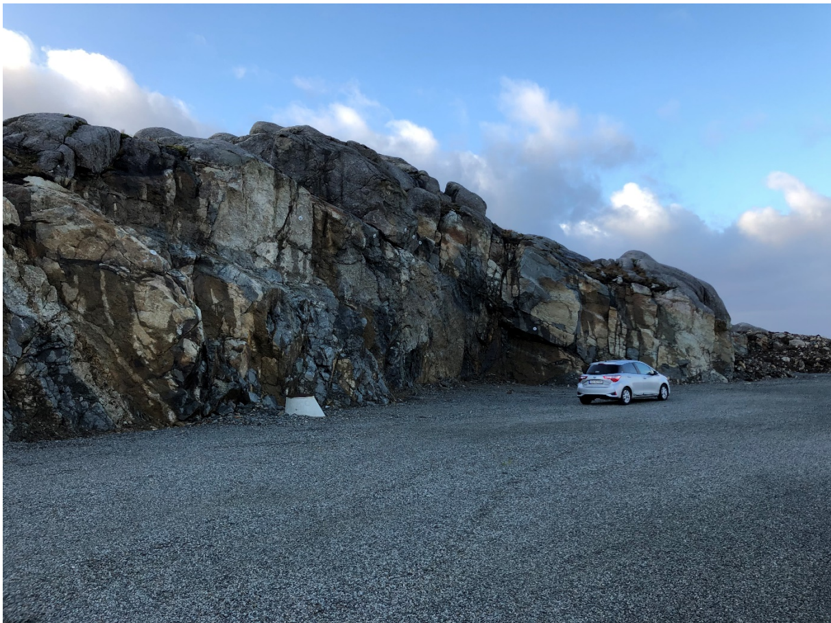
Figur 6-11: Lokalitet S45 oversiktsbilde, noen svært utholdende sprekker.
