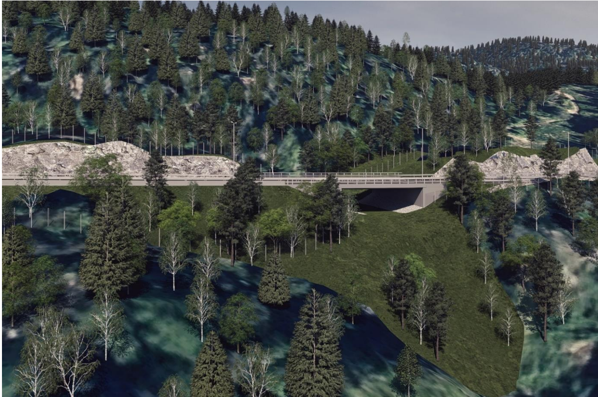
Figur 8-13: Hegland faunapassasje under bru. Her er det sikret tilstrekkelig bredde (20 m), og det er satt av plass til beitevegetasjon. (Kilde: Sweco).
