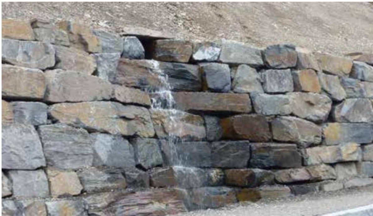
Figur 8-2: Eksempel på støttemur. (Kilde: Estetisk veileder, [1]).
