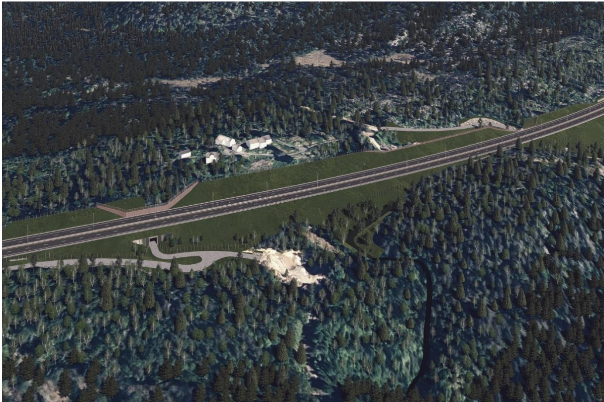
Figur 8-1: Terrengbehandling ved Brynemo. Overskuddsmasser er brukt til å etablere en støyvoll, lokalveiforbindelse er plassert inn i terrenget. (Kilde: Sweco).
