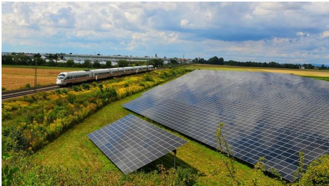
Figur 40: Bakkemontert solcellepark i tilknytning til jernbanen [25].
