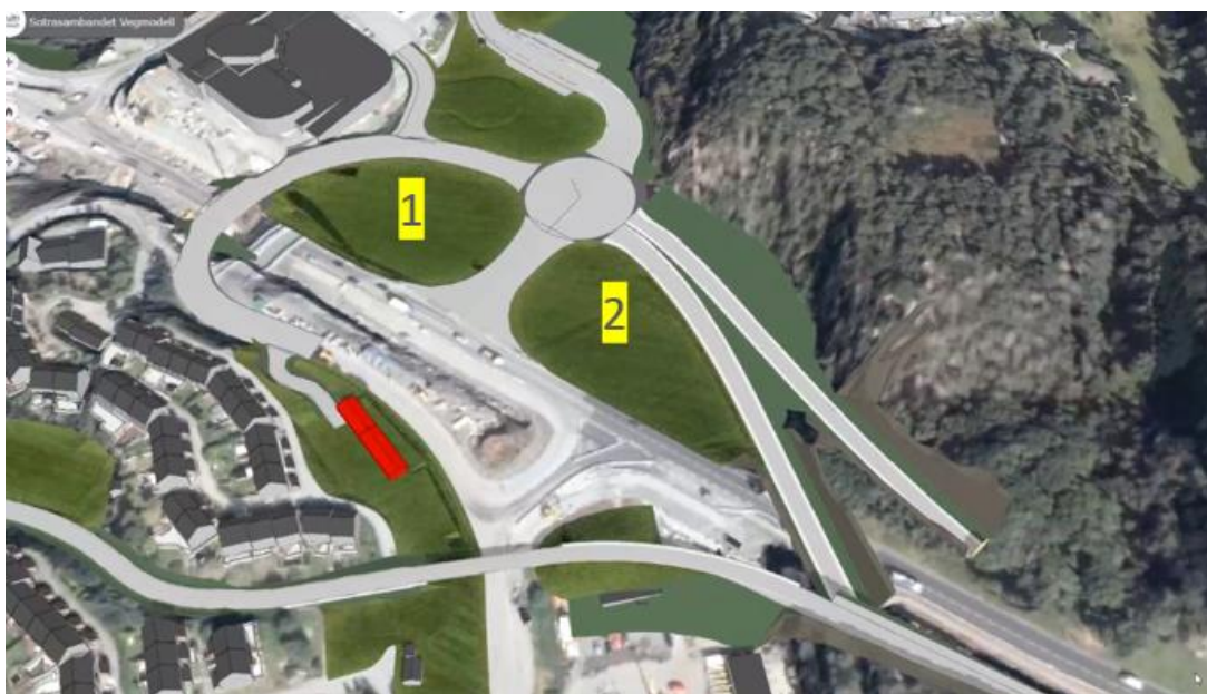
Figur 23: Tilgjengelige arealer på totalt ca. 6 600 m 2 ved en rundkjøring vest for Vikafjellet i Sotrasambandet [27].
