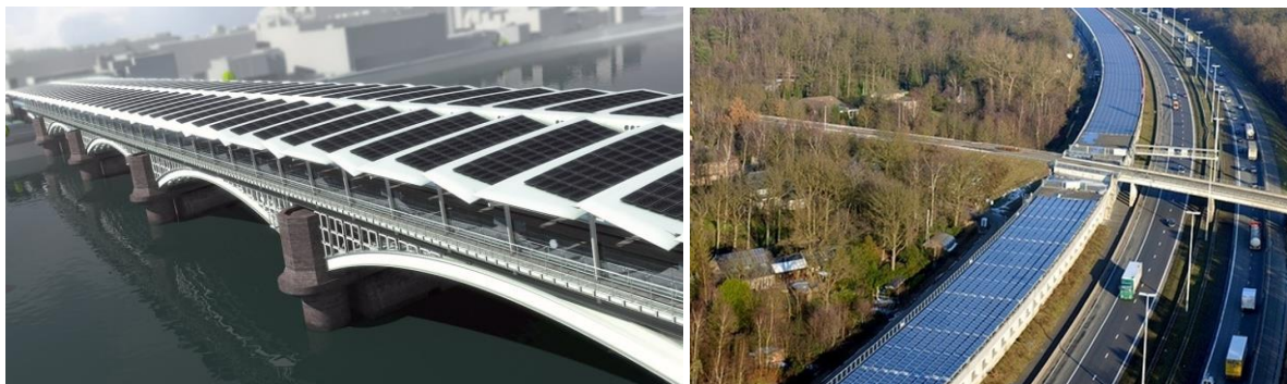
Figur 34: Solceller på taket over høyhastighetstog i Blackfriars i London (venstre) [39] og solceller på taket over jernbanen i Antwerp i Belgia (høyre) [40].
