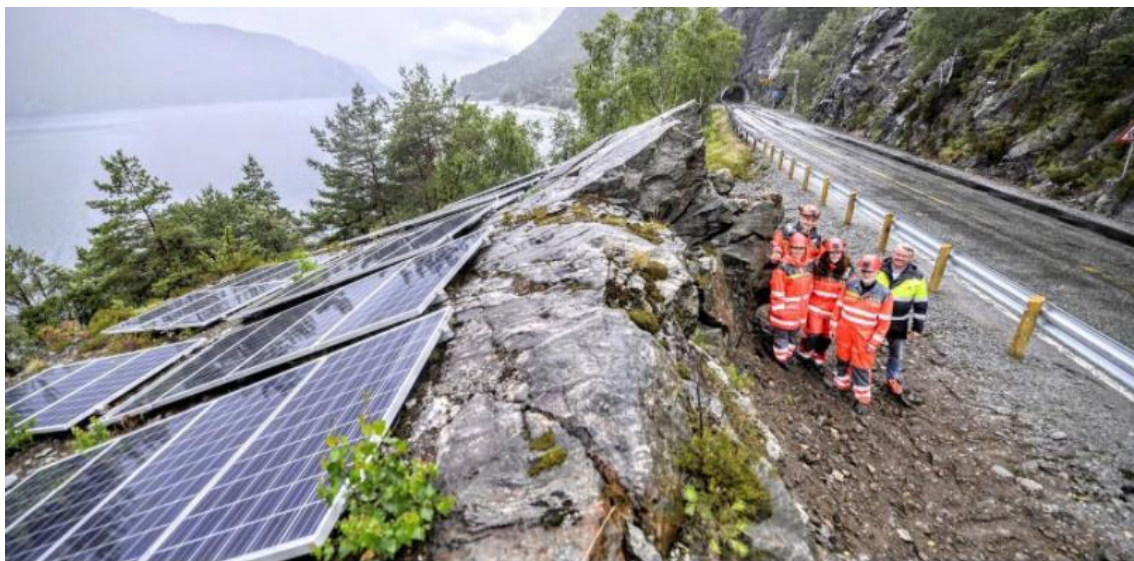
Figur 26: Tunnelbelysning med strøm fra solceller i Kjöldalstunnelen [33].
