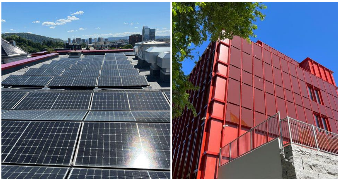
Figur 1: Ballastert solcelleanlegg på tak (venstre) og bygningsintegrerte solceller (høyre) på Sofienberg skole. Foto: Multiconsult.
