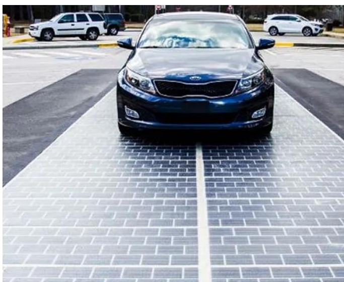
Figur 33: Wattway sin løsning med solceller integrert i veibanen [38].
