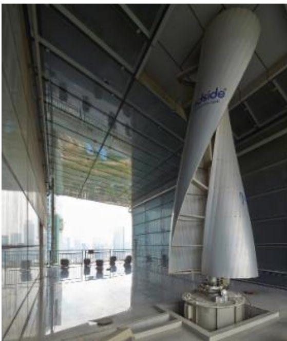
Figur 8: Vindturbin integrert i bygg på Pearl River Tower i Guangzhou, Kina [8].
