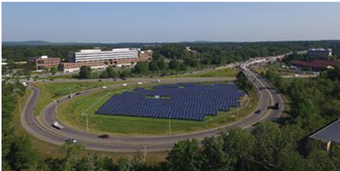
Figur 32: Solceller ved avkjøring 13 nord på Massachusetts Turnpike (I-90) i Framingham. [37]
