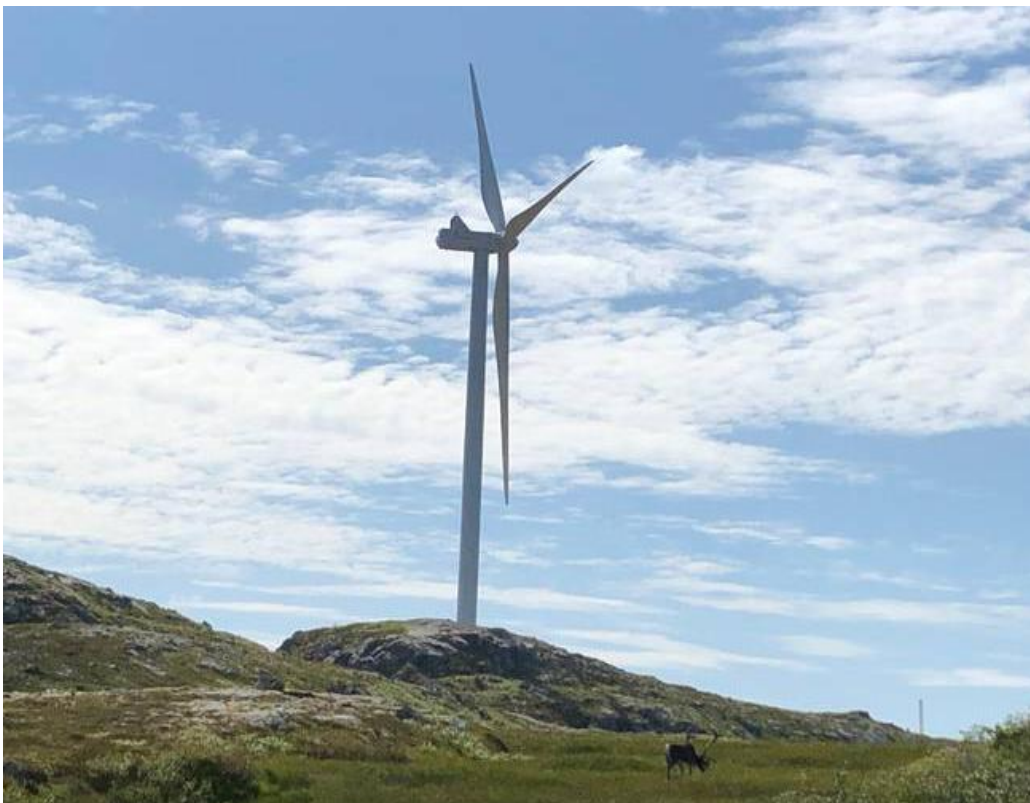
Figur 10: Vindturbin i Storheia vindpark i Åfjord kommune og Ørland kommune. Vindturbinen er av typen V117 på 3,6 MW og er 87 m høy [12] [13].
