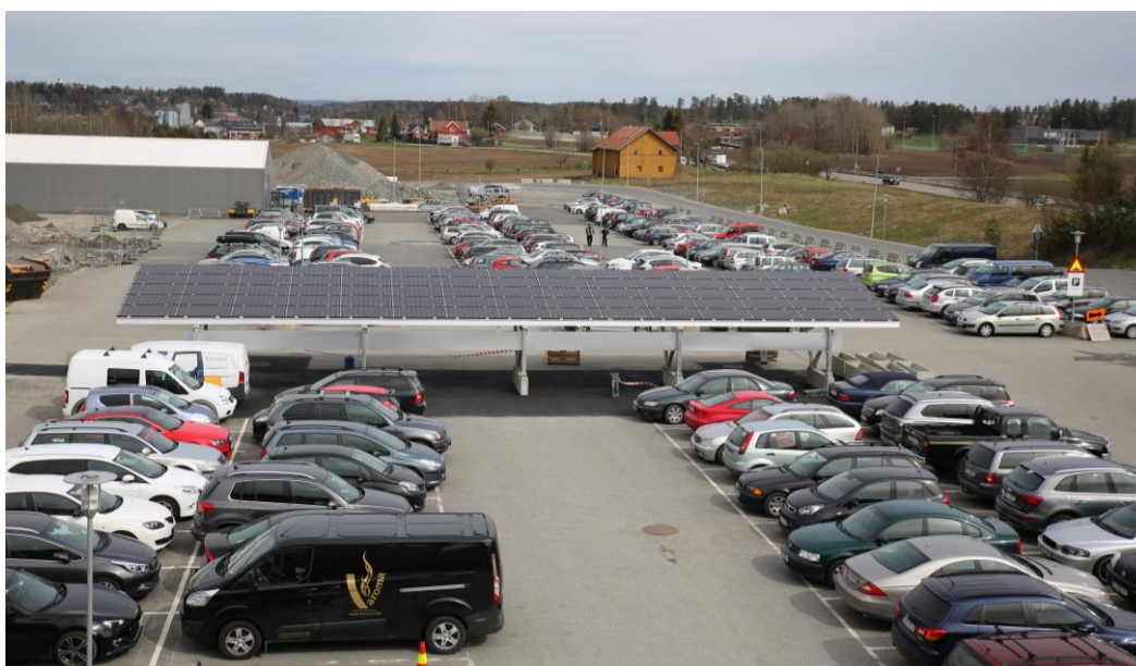
Figur 25: Carport med elbillading på Asko i Vestby [30].
