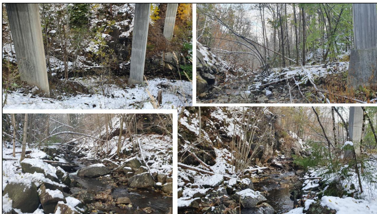
Figur 11-4: Bilder som viser berg i dagen og steinmasser under Tyvansselvas bru (Foto: Sweco BRU)
