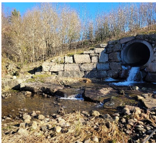
Figur 4-4. Vandringshinder under dagens E39 i Tjomslandsbekken. Foto: Sweco, 2022.
