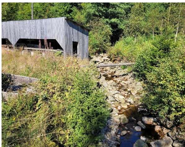
Figur 5-4. Bekk øst for Trimbråsen sett oppstrøms veien Dragedalen. Foto: Sweco, 2022.
