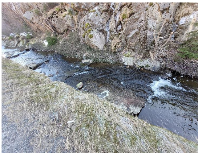
Figur 4-5. Bekkebunn av betong i Tjomslandsbekken oppstrøms dagens E39. Foto: Sweco, 2022.
