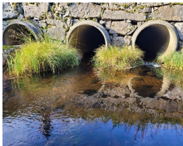
Figur 4-8. Kulverter under dagens E39 i Hålandsbekken. Foto: Sweco, 2022.
