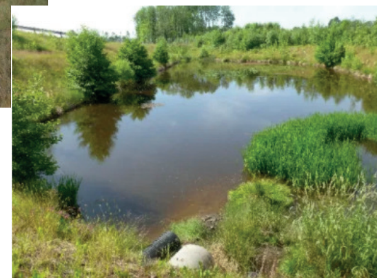
Venstre: Åpen, bred og grønn filtergrøft langs vei. Høyre: Eksempel på sedimentasjonsbasseng med permanent vannspeil langs veg. Foto: "Naturbasert håndtering av forurenset overvann fra veg", Åstebøl, COWI AS, 2020
