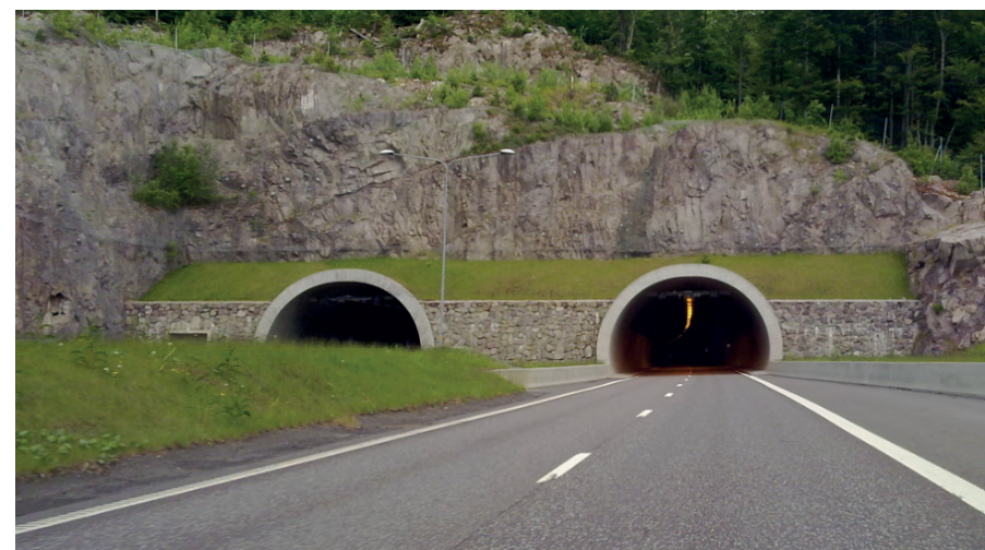
Portaler med natursteinsmur. E18 Vinterbro. Foto: Wichada Treepoonpon
