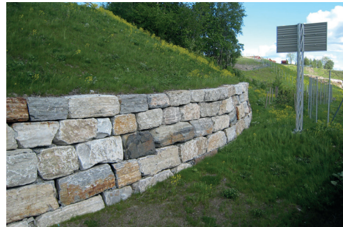
Natursteinsmur ved E16 Bjørum i Bærum. Foto:SVV
