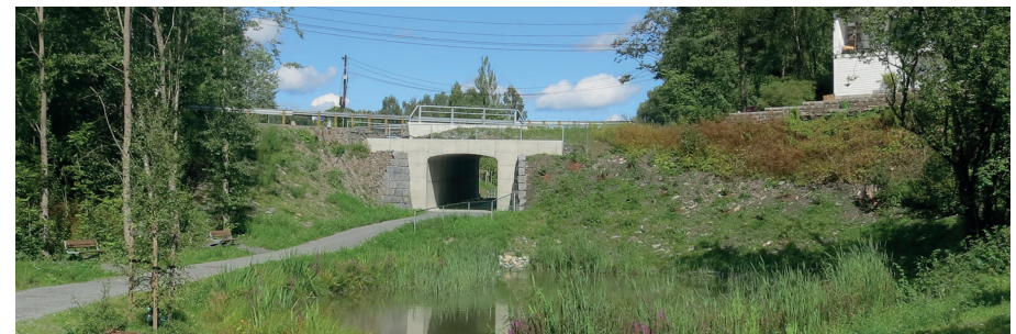
Kulvert med plasstøpt portal i Skytterdalen. (Foto: Wichada Treepoonpon).
