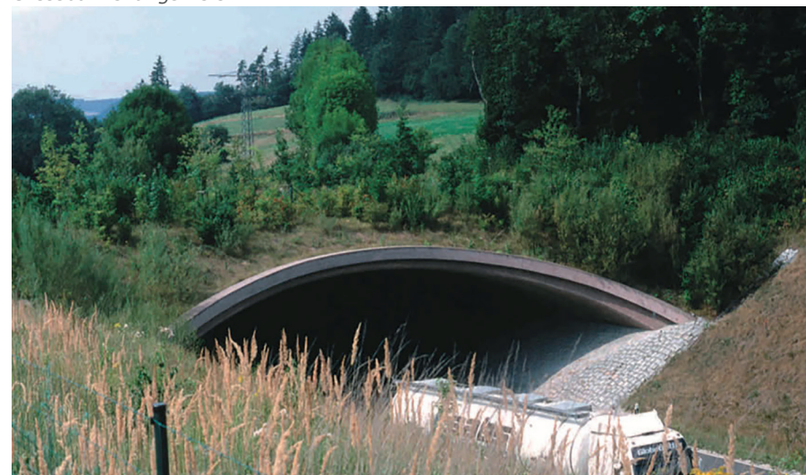
Beplantet faunapassasje ved Schwarzgraben i Sør-Tyskland. (Foto: V. Keller)
