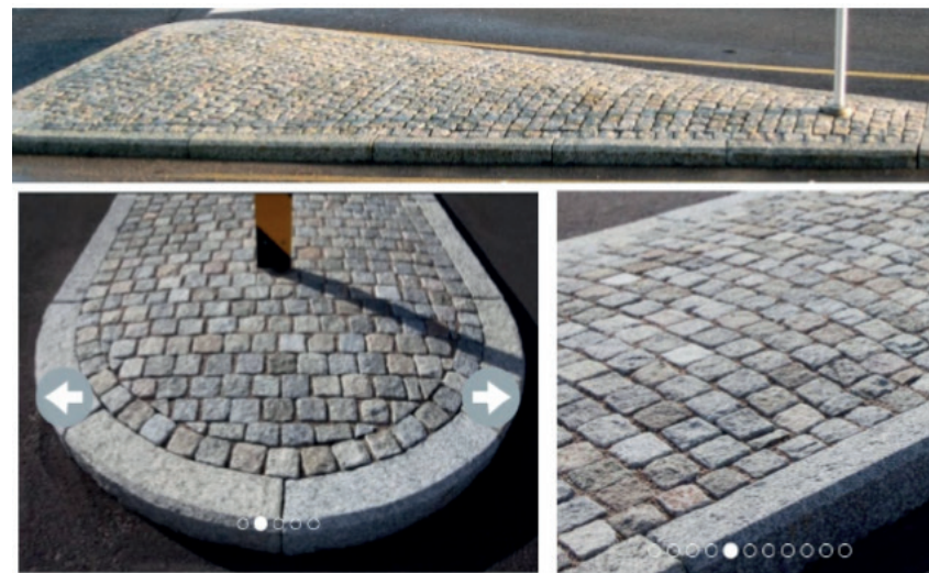
Trafikkøy/ rabatt med smågatestein med rulleskift mot kantstein. Bilde fra "Løsninger og materialbruk i kryssområder", prosjektet E39 Mandal Øst - Mandal by. Hæhre, 2020
