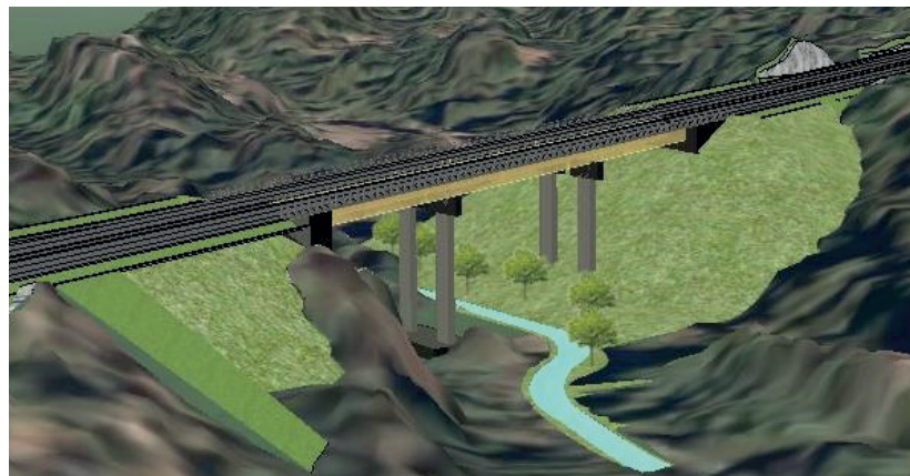
Parti under Høylandsbekken bru. Det er sikret plass til bekkeomlegging, ny randsone og et slakt, åpent parti for faunapassasje. I tillegg bevares en stor del av det eksisterende terrenget under brua.
