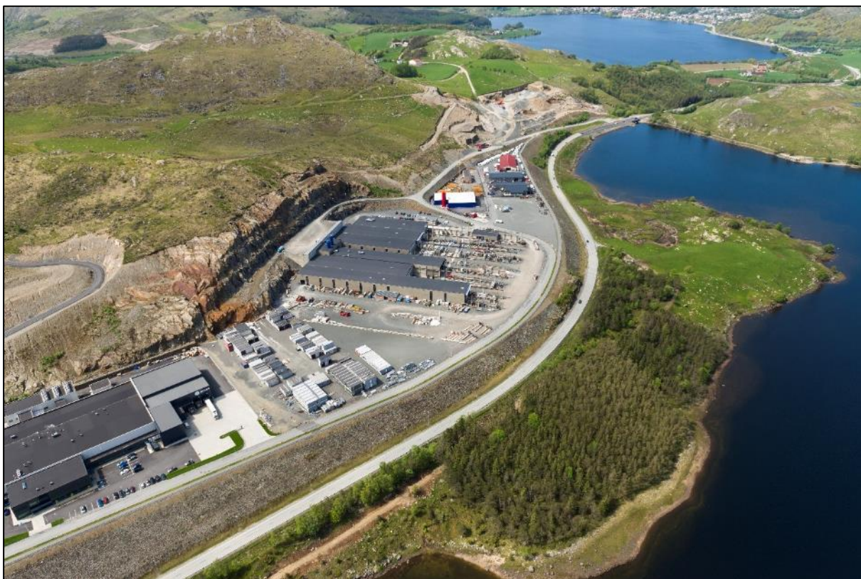
Figur 6-63: Delområde J12 Måganeset sett fra helikopter. Måganeset er neset som stikker ut i Klugsvatnet til høyre i bildet. (Kilde: Statens vegvesen).
