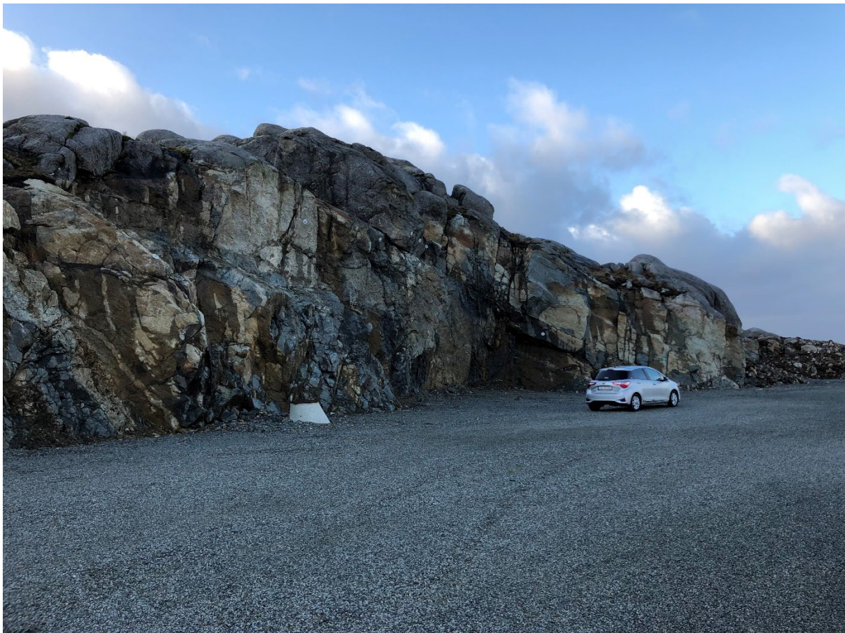
Figur 6-11: Lokalitet S45 oversiktsbilde, noen svært utholdende sprekker.
