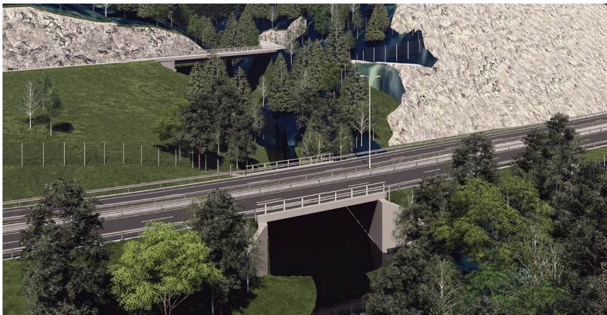
Figur 4-28: Dørdal 4 kulvert – faunapassasje under E18 for mindre hjortedyr. Sett mot nord. I bakgrunnen skimtes ny Rørholtveien bru for den omlagte Rørholtveien. (Kilde: Sweco).
