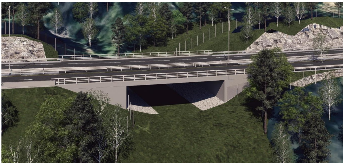
Figur 4-25: Hegland kulvert – faunapassasje under E18. Sett mot nord. (Kilde: Sweco).
