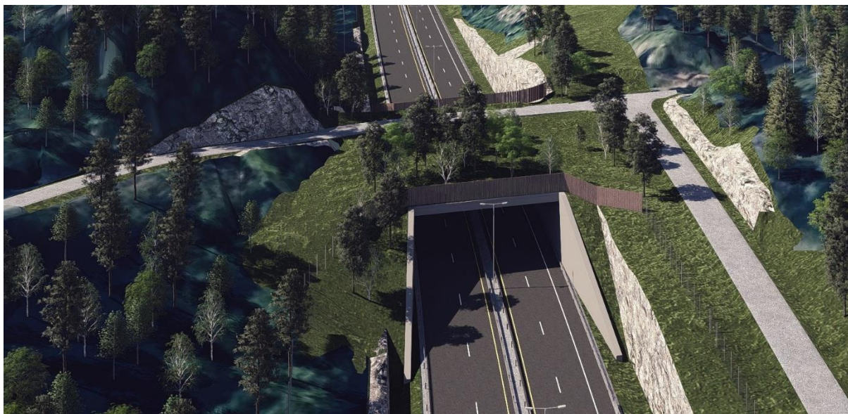
Figur 4-26: Plassen kulvert – faunapassasje over E18. Sett mot vest. (Kilde: Sweco).
