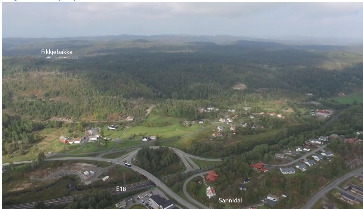
Figur 6-49: Oversiktsbilde over nordlig del av delområdet ved eksisterende kryss, sett fra sørøst. Foto: Utsnitt fra helikopterfilm tatt opp i sammenheng med KDP Dørdal – Grimstad, 2018.
