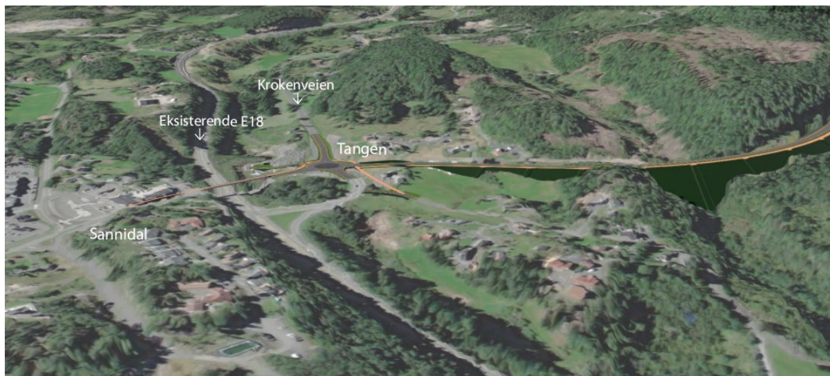
Figur 6-50: Gjennomgangstrafikk flyttes fra eksisterende E18, og veien får vesentlig redusert trafikkmengde og lydbildet blir forbedret. Sett fra nordøst mot sørvest.
