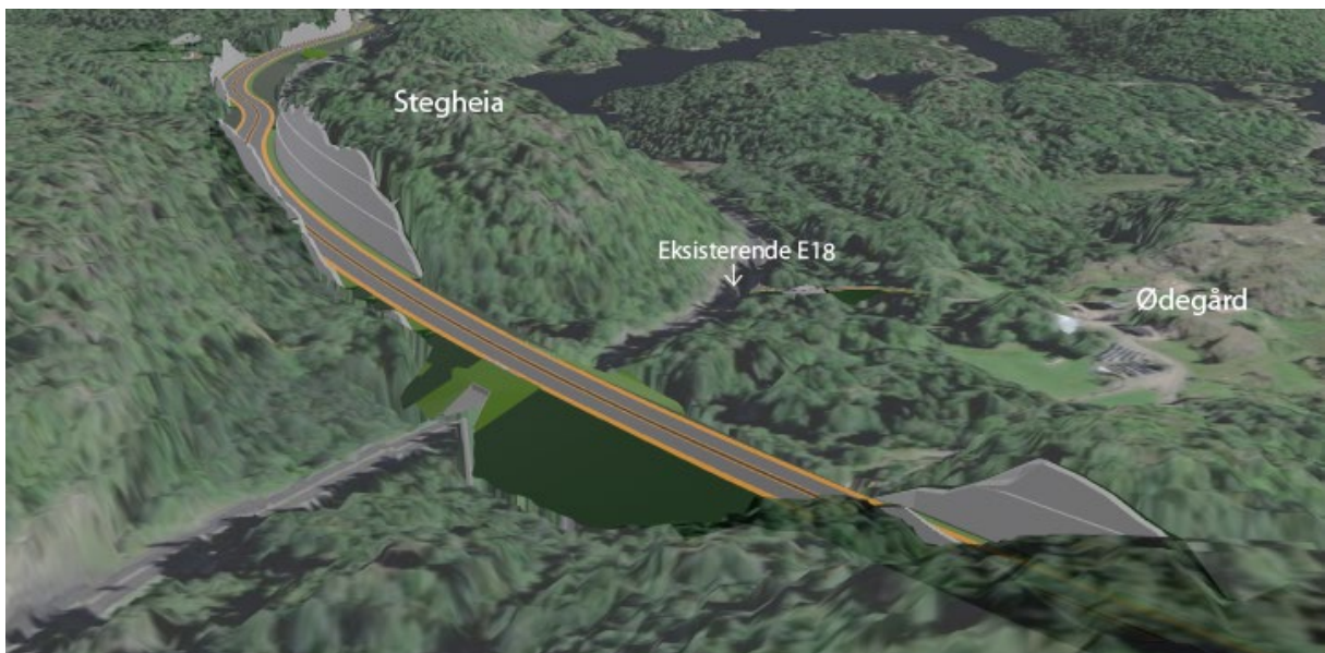
Figur 6-28: Ny E18 vil ligge i skjæring ved Stegheia og dagens trasé av postveien blir berørt av det nye veianlegget. Sett fra vest mot øst.
