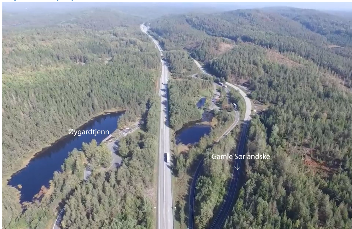
Figur 6-57: Oversiktsbilde over eksisterende rasteplass ved Øygardtjenn, sett fra sørvest. Gamle Sørlandske går langs eksisterende E18 i øst. Foto: Utsnitt fra helikopterfilm tatt opp i sammenheng med KDP Dørdal – Grimstad, 2018.
