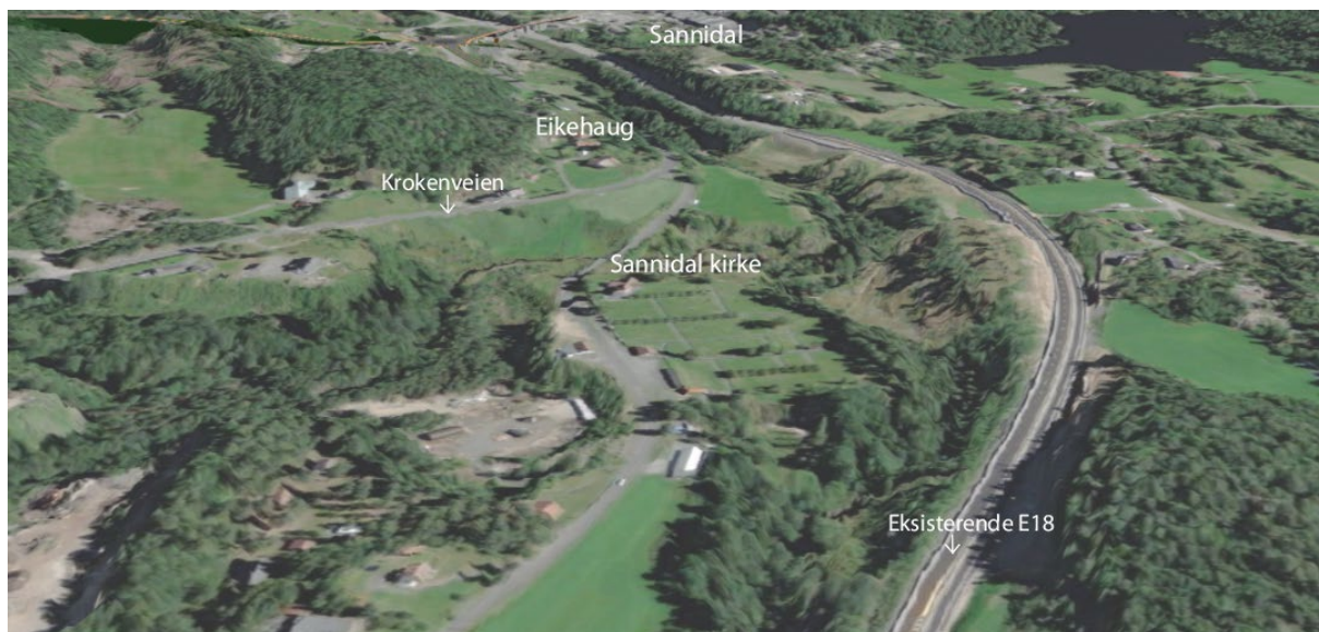
Figur 6-51: Nedsatt barriere gir grunnlag for bedret tilgjengelighet mellom områder langs Krokenveien, kirken samt området ved Eikehaug, og Sannidal. Sett fra øst mot vest.
