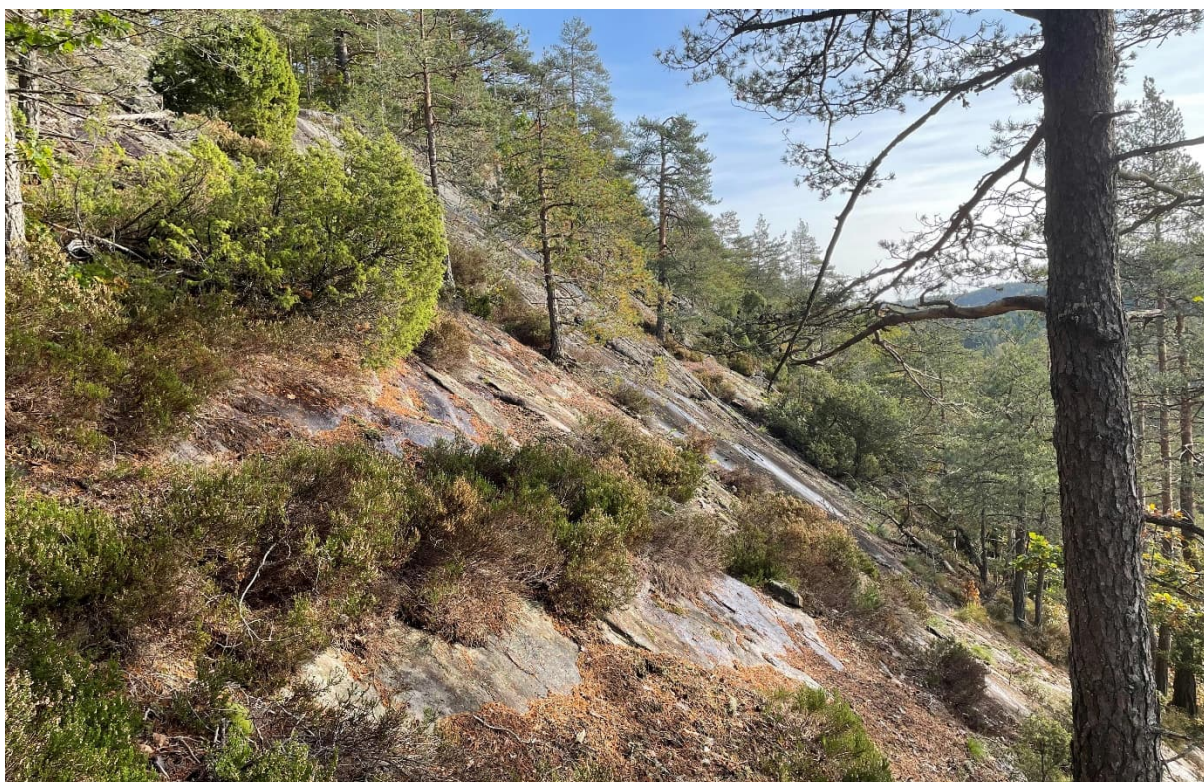
Figur 14-4: Svaberg med helning rundt 35-40° i overkant av hovedveien mellom profil 17520-17590 på venstre side. Planlagt bergskjæring vil berøre dette området. Sett mot øst. Fotograf Ingvild Sangesland Qvist.
