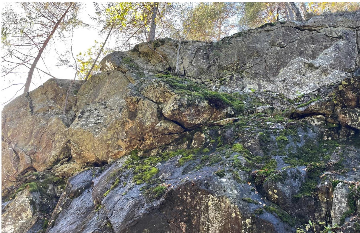
Figur 11-7: Avløste blokker observert i bergskrent ved ca. profil 2350 til venstre for sidevei 63022. Sett mot vest. Fotograf Ingvild Sangesland Qvist.
