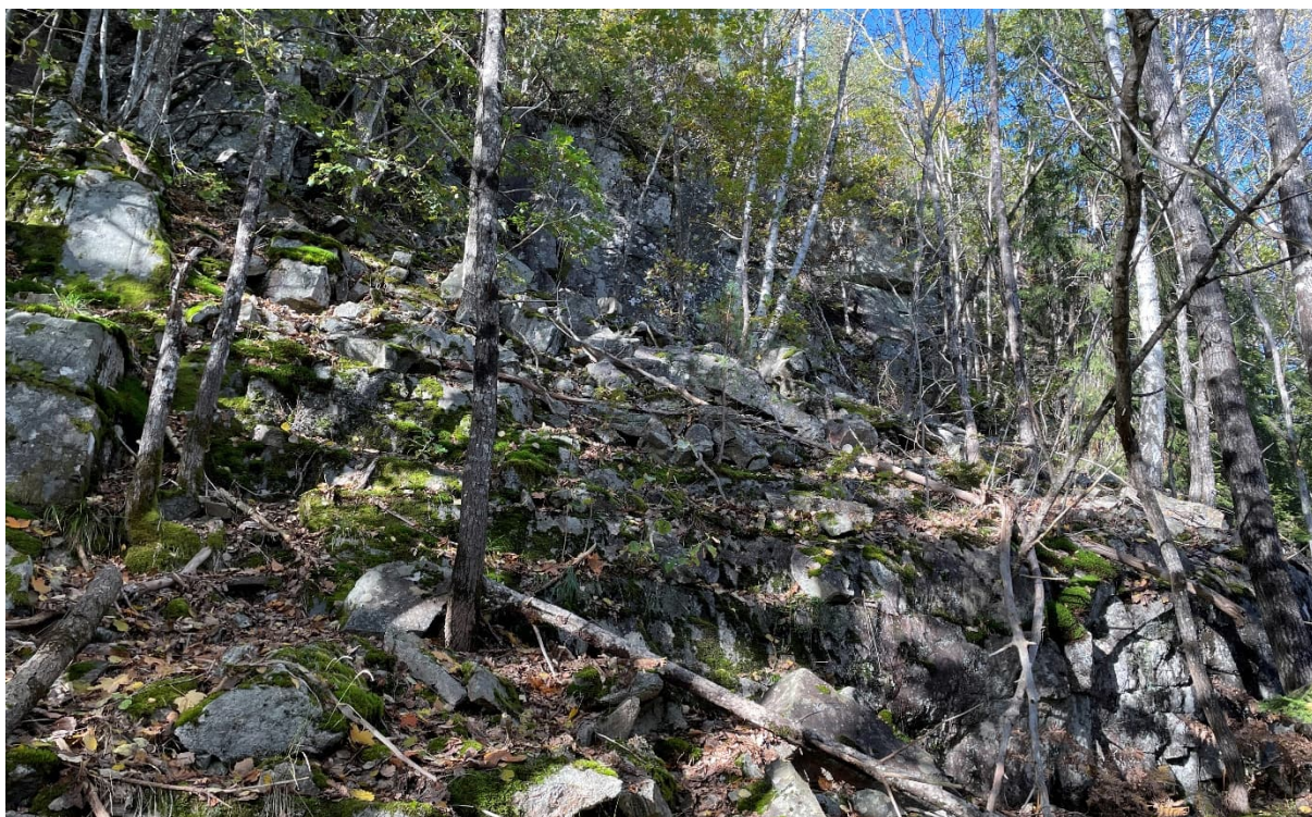
Figur 9-8: Urmasser i underkant av bergskrent til venstre for hovedvei ved ca. profil 10050. Sett mot nord. Fotograf Ingvild Sangesland Qvist.
