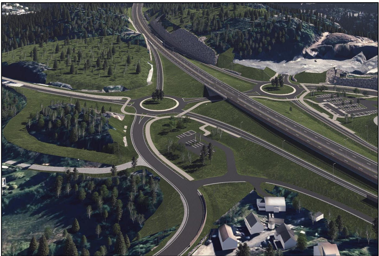
Figur 3-26: Kryss ved Gjerdemyra, utformes som et ruterkryss, sett fra vest. (Kilde: Sweco)
