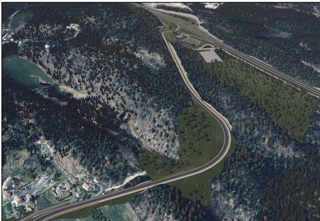
Figur 3-14: Sideveien mellom Humlestad og fremtidig E18, sett fra øst. (Kilde: Sweco)
