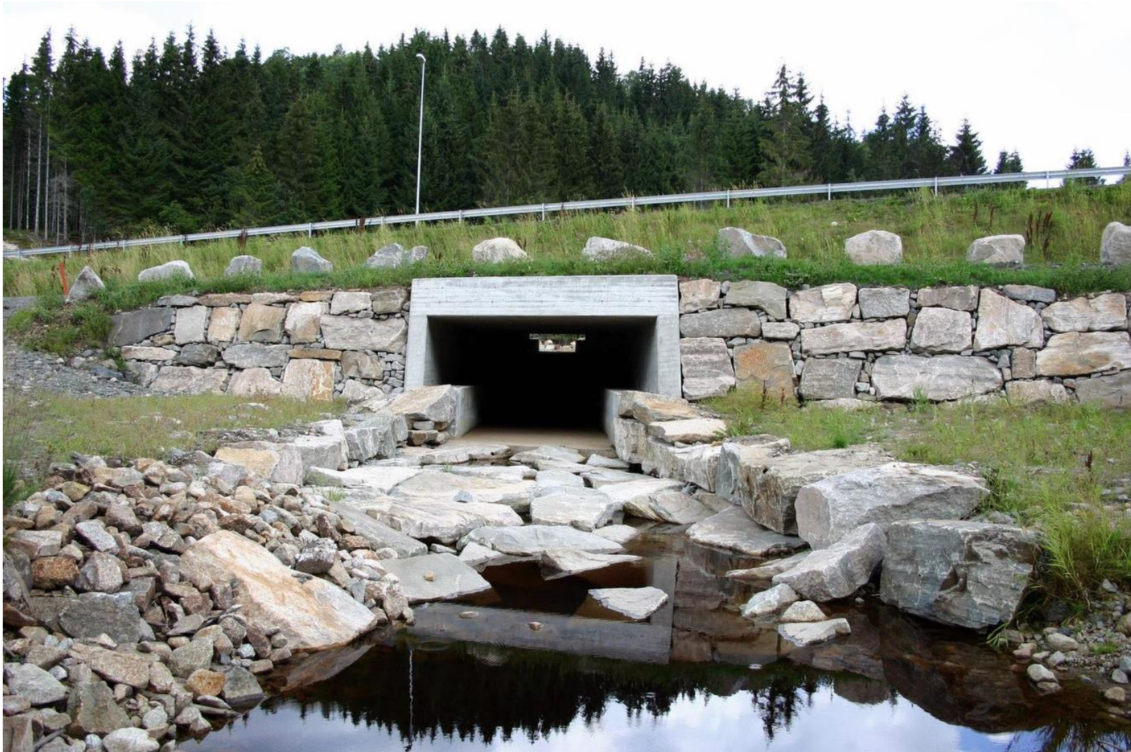
Figur 8-4: Utløp kulvert/bru veiprofil 6660 Botnebekken.
