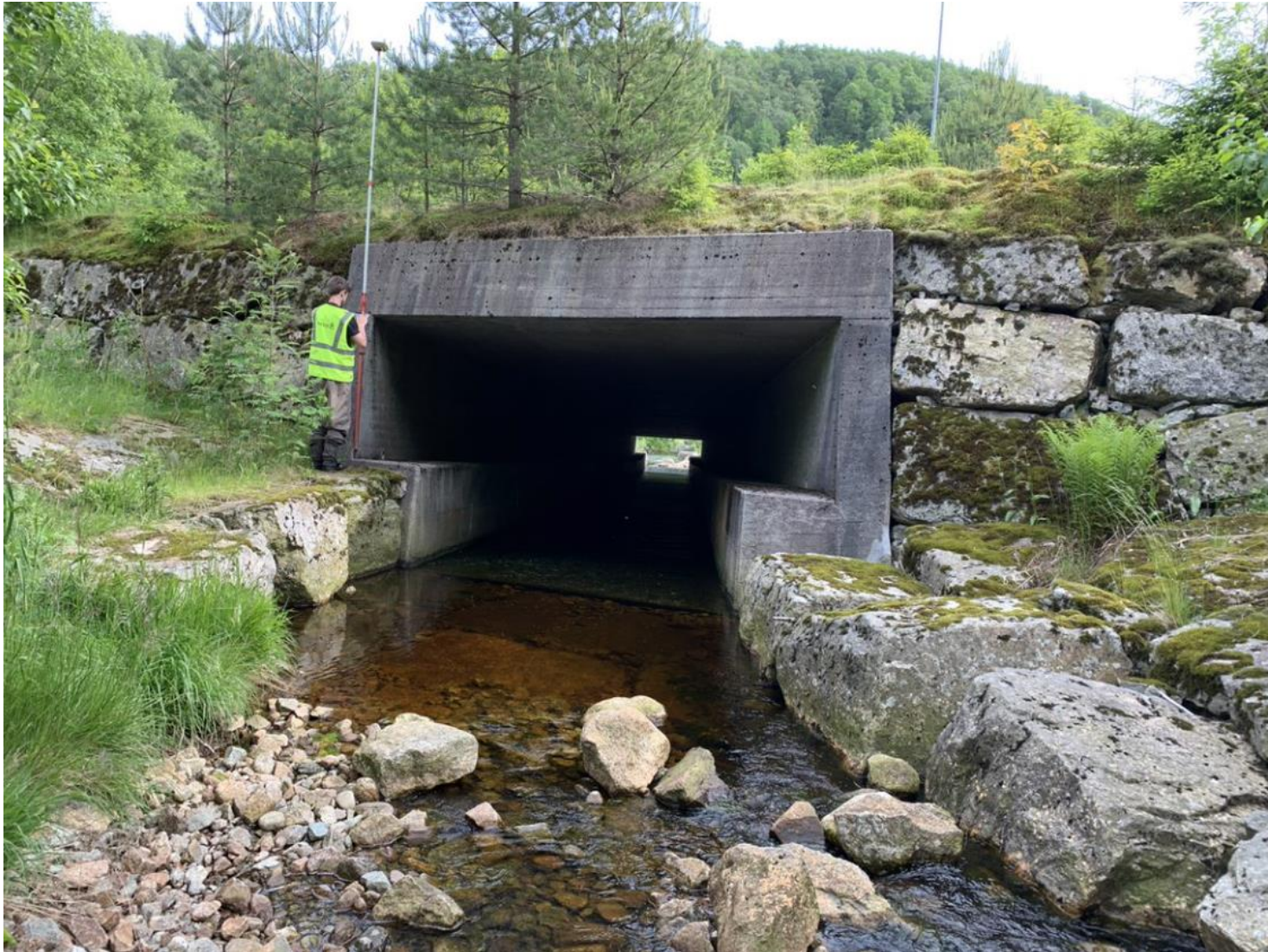
Figur 8-3: Innløp kulvert/bru veiprofil 6660 Botnebekken.
