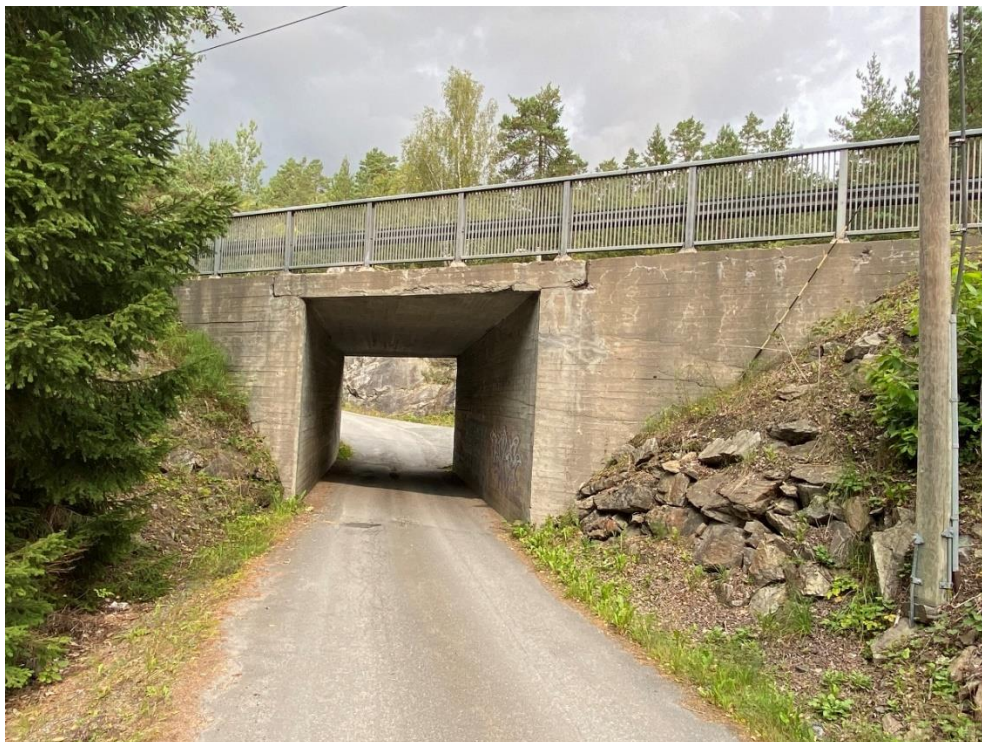
Figur 3-51: 08-0718 Dørdal 5, kulvert under E18. (Kilde: Sweco).
