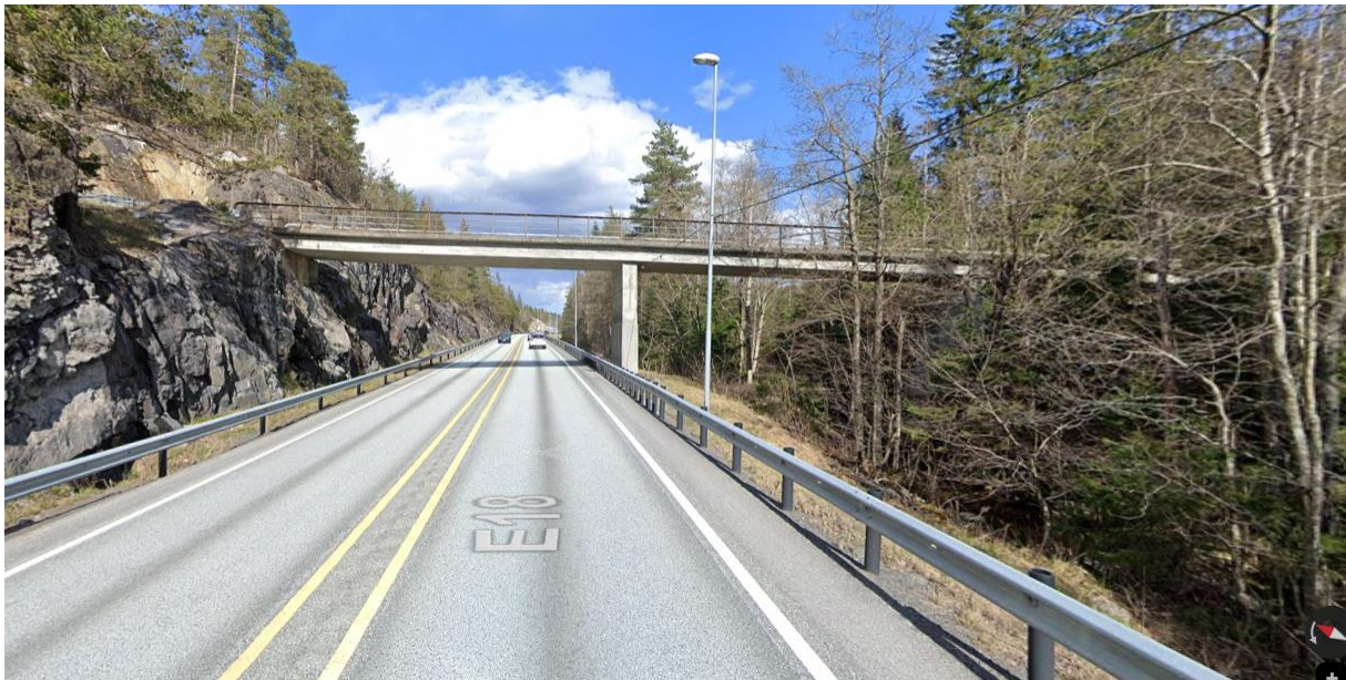
Figur 3-42: 08-0757 Handfang bru (Rørholtveien). (Foto: Google Street view).
