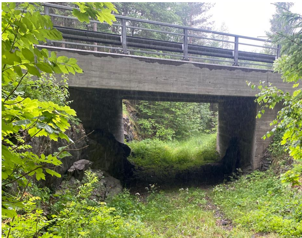
Figur 3-15: Kulvert ved Ødegård. (Kilde: Sweco).
