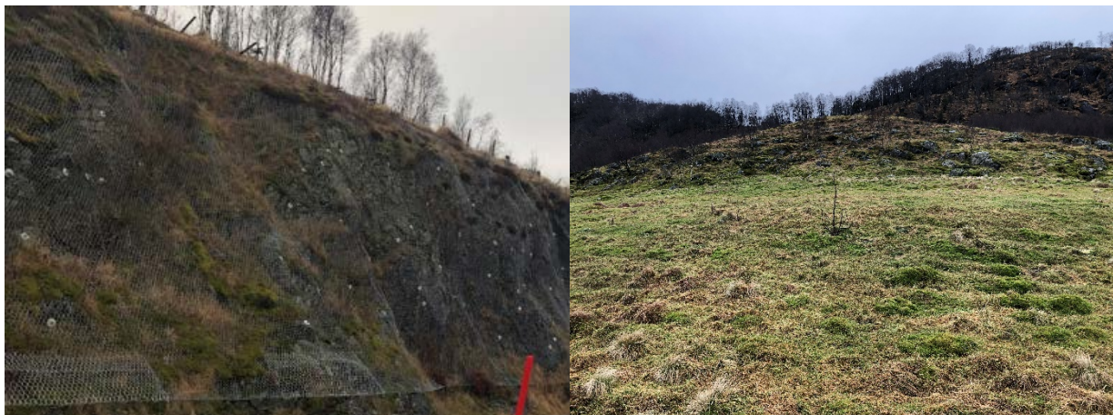
Figur 6-19: Bilde t.v. tatt mot NV, lokasjon S30, eksisterende skjæring ved E39, bilde t.h. tatt mot SØ. Forsenkning i terrenget mellom to bergknauser. Lokasjon S59.
