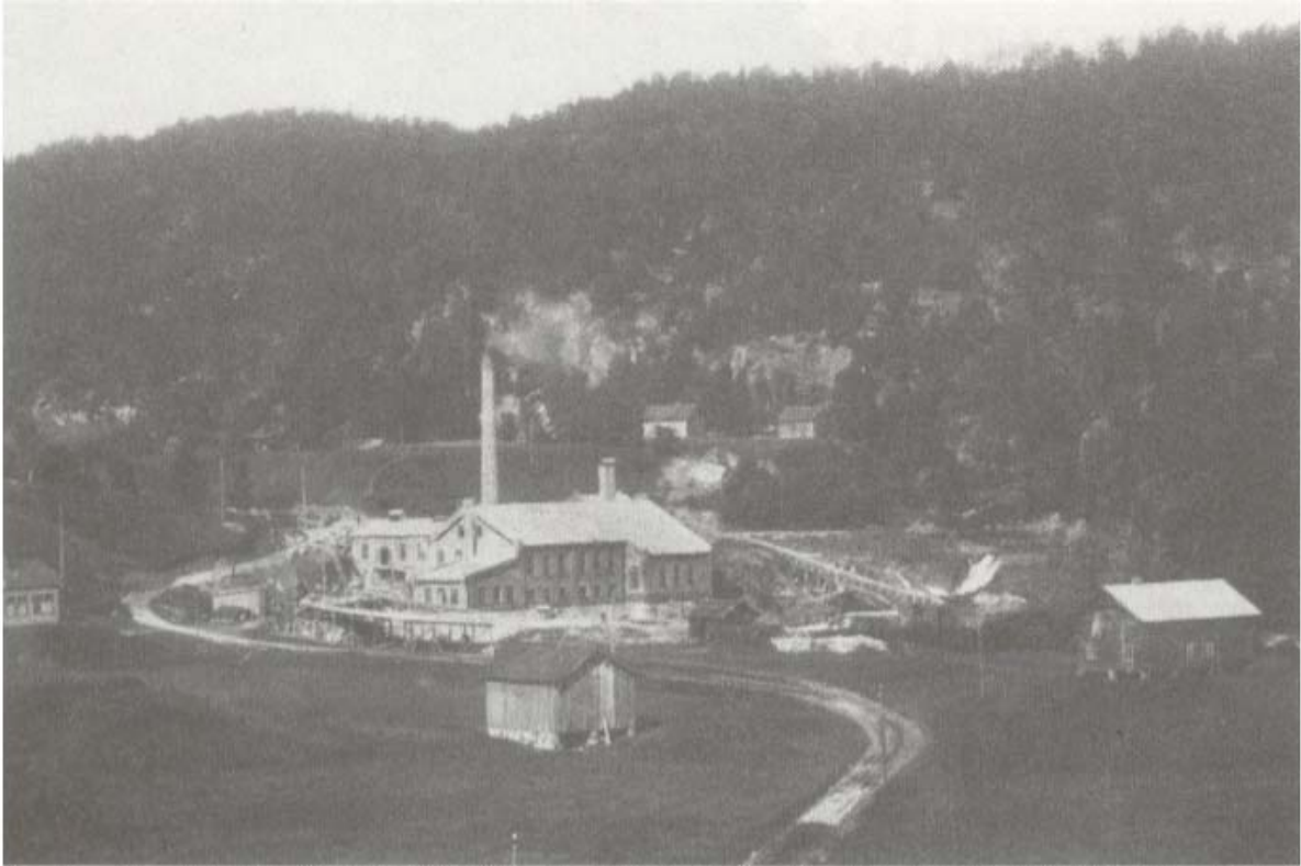
Figur 6-116 Sliperiet på Fosstveit var i drift frem til 1970. Sliperiet brukte vannkraft fra elva, og tømmeret ble i stor grad fløtet på Storelva. Vannveien sørget dermed både for transport og energi. Kilde: Christensen 1983: 14/Tvedestrand kulturminneplan 2021-2024: 20.
