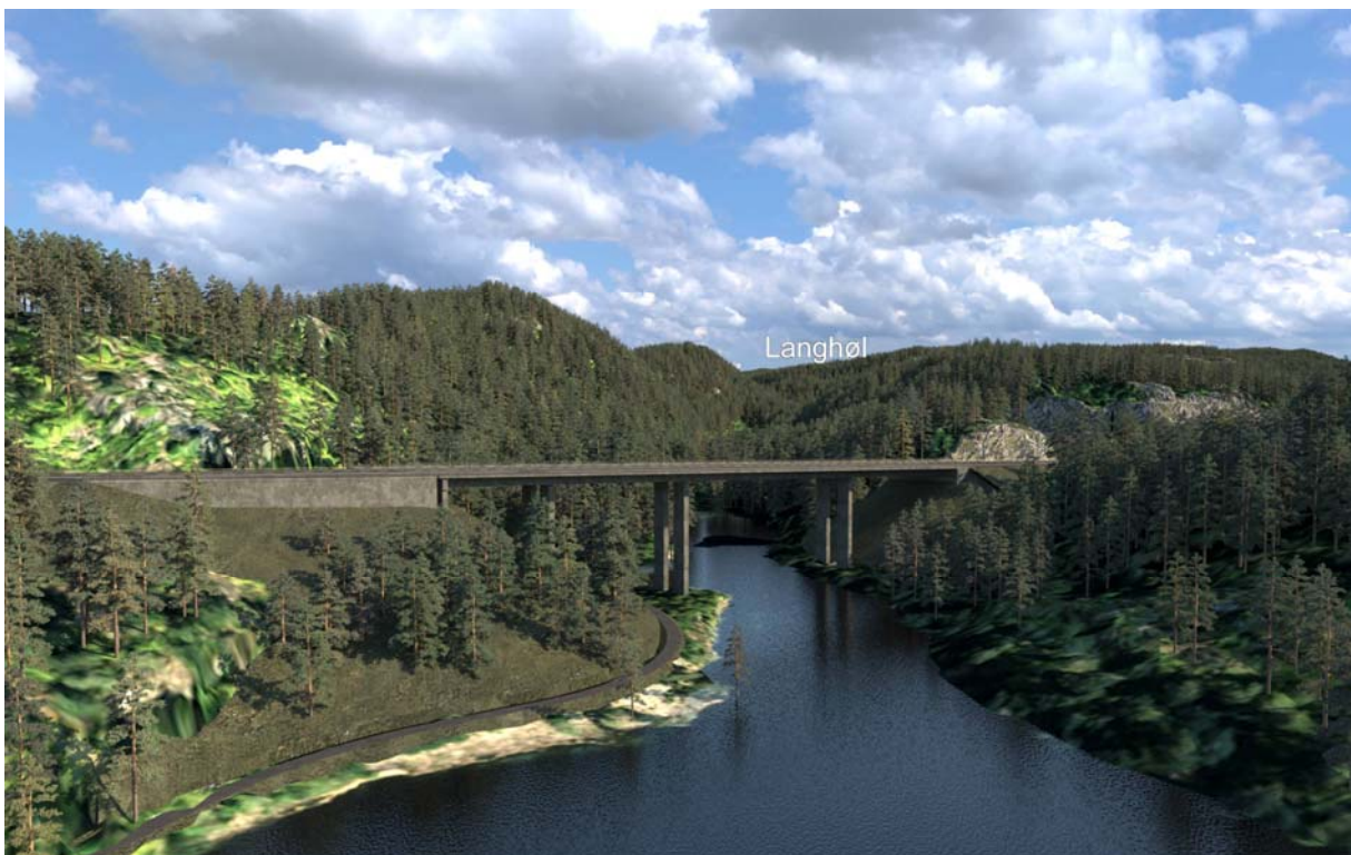
Figur 6-81 Illustrasjon som viser ny E18 i bru over Langhøl. Kilde: COWI AS, 2021
