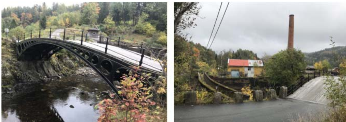
Figur 6-115 T.v.: Fotografi av Fosstveit jernbru som er fredet. T.h.: Fotografi av miljøet ved Fosstveit. Kilde. COWI AS, 2020.
