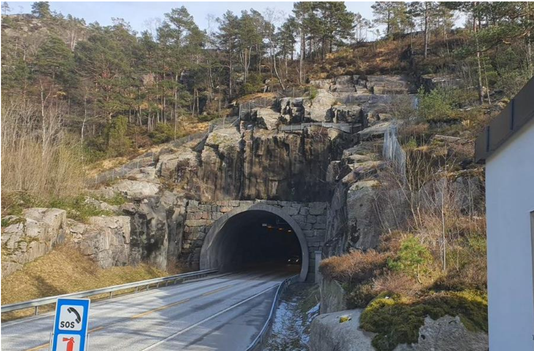
Figur 4-16: Bilde av det vestlige tunnelpåhugget for Vatlandstunnelen. Nytt løp kommer på høyre side i bildet.
