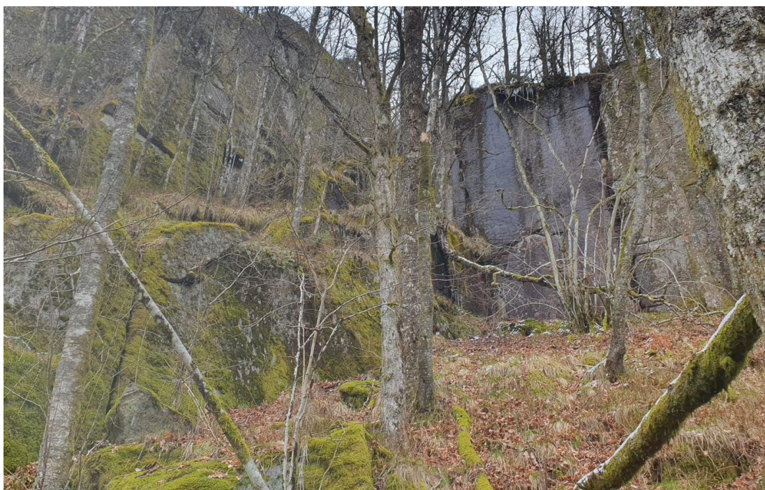
Bildevedlegg 2: Brattskrenter ca. 25 m etter planlagt påhugg.
