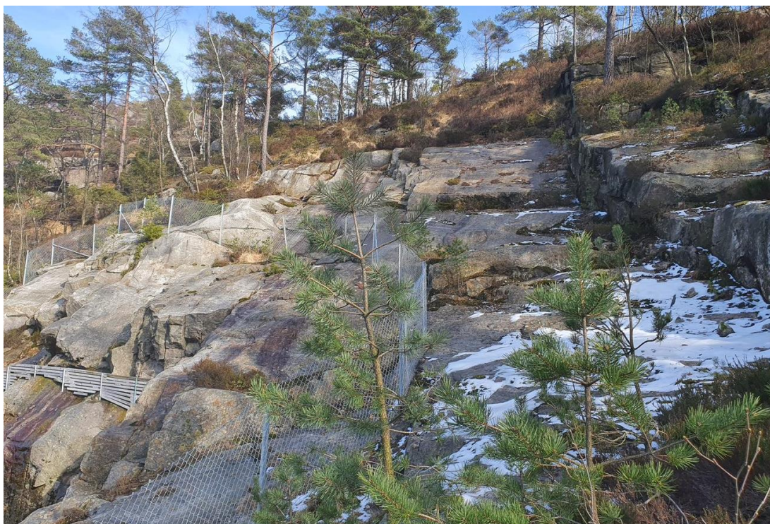
Bildevedlegg 3: Bergoverflaten på toppen av Vatlandstunnelen påhugg vest.
