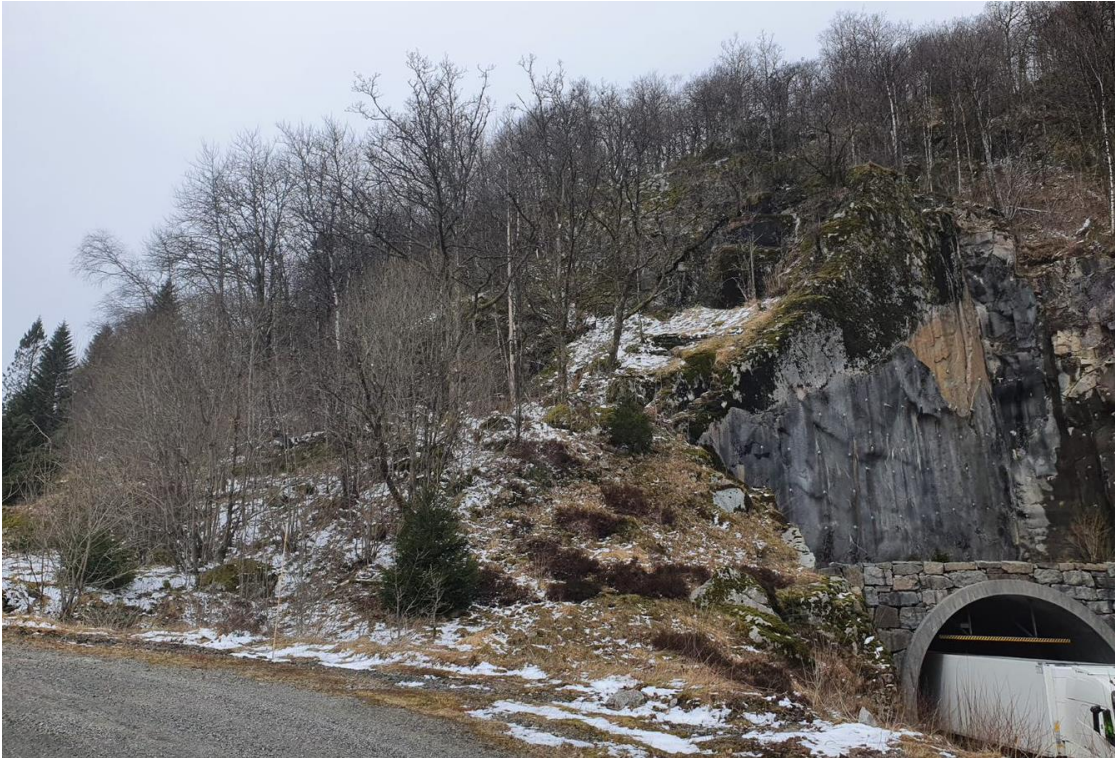
Figur 4-10: Bilde av østlig påhuggsområde for Vatlandstunnelen. Påhugg til eksisterende løp kan ses til høyre.
