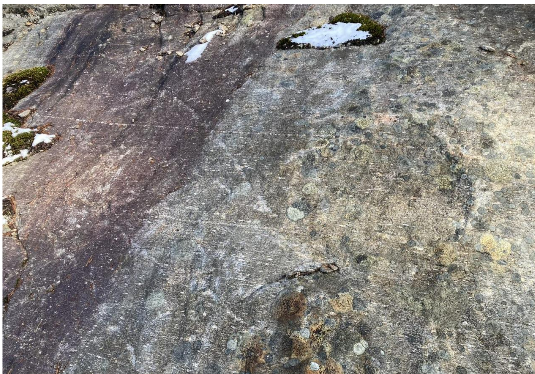
Figur 4-6: Bilde av bergarten (Granittisk gneis) ved det vestlige påhugget.
