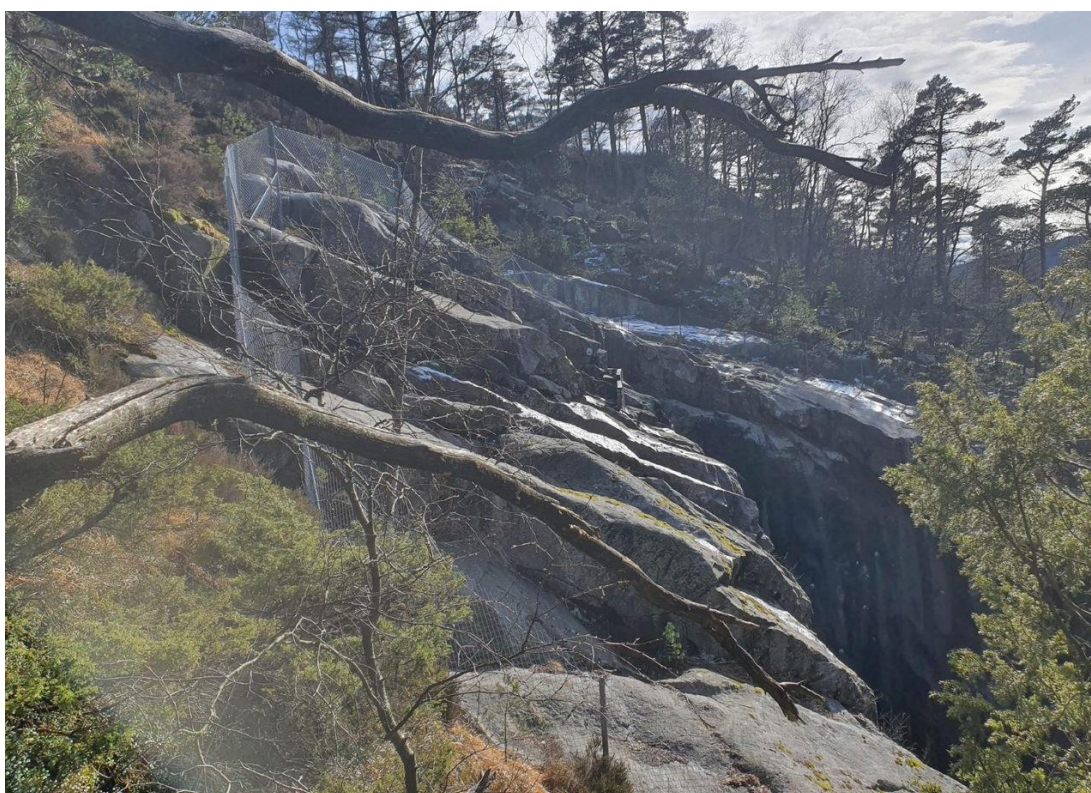
Bildevedlegg 4: Vatlandstunnelen påhugg vest. Bilde tatt mot området hvor ny forskjæring skal etableres (mot sør)
