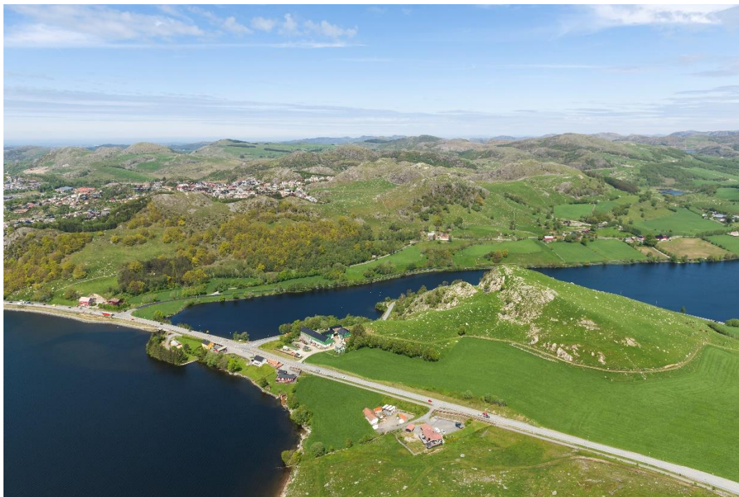
Figur 6-21: Dagens E39 på fylling mellom Edlandsvatnet og Limavatnet. Foto: Statens vegvesen.
