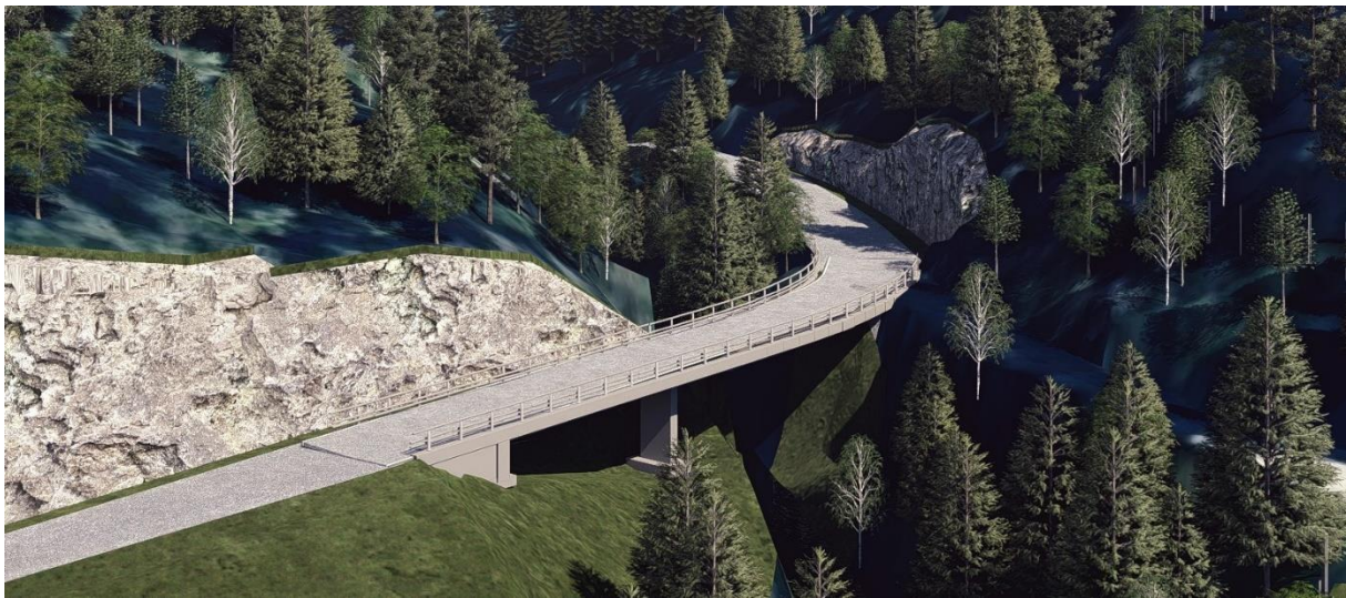
Figur 4-20 Rørholtveien bru. Sett mot nordøst (kilde: Sweco).
