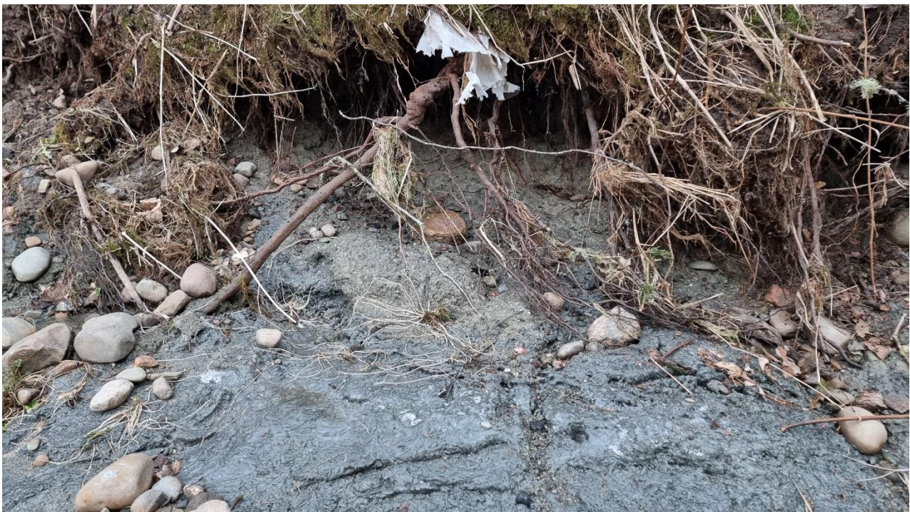
Undergraving av vegetasjonsdekket.
