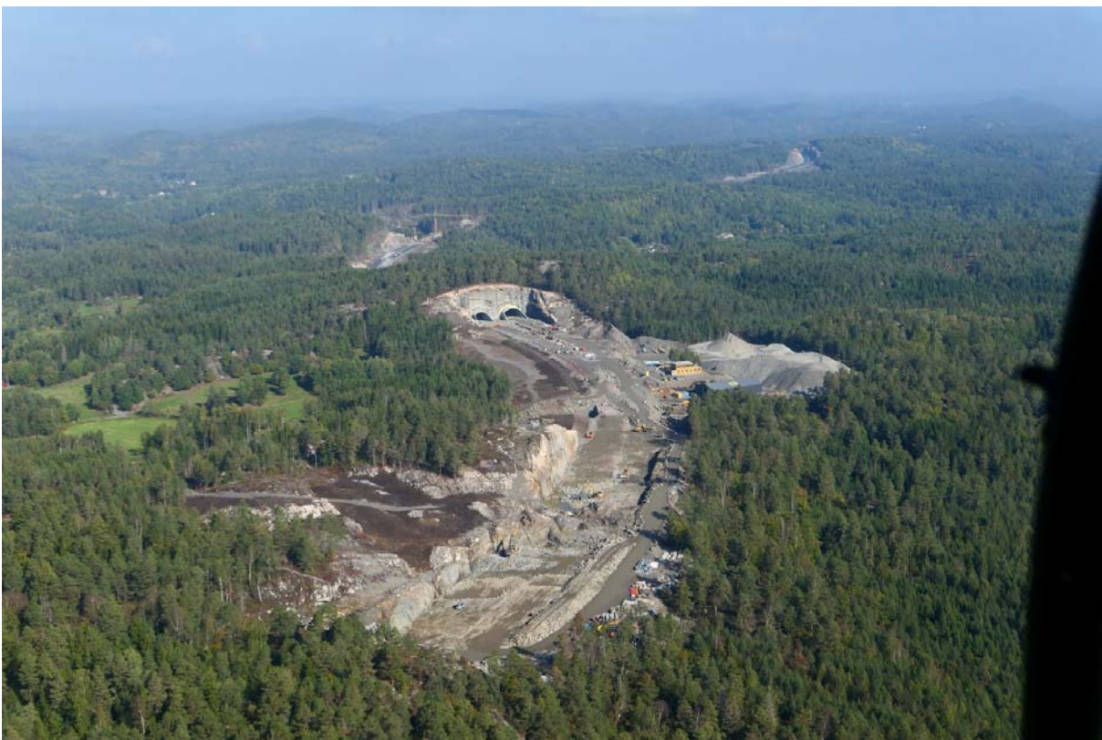
Figur 28. Tilsvarende bilde E18 Arendal-Tvedestrand noe lenger nord.
