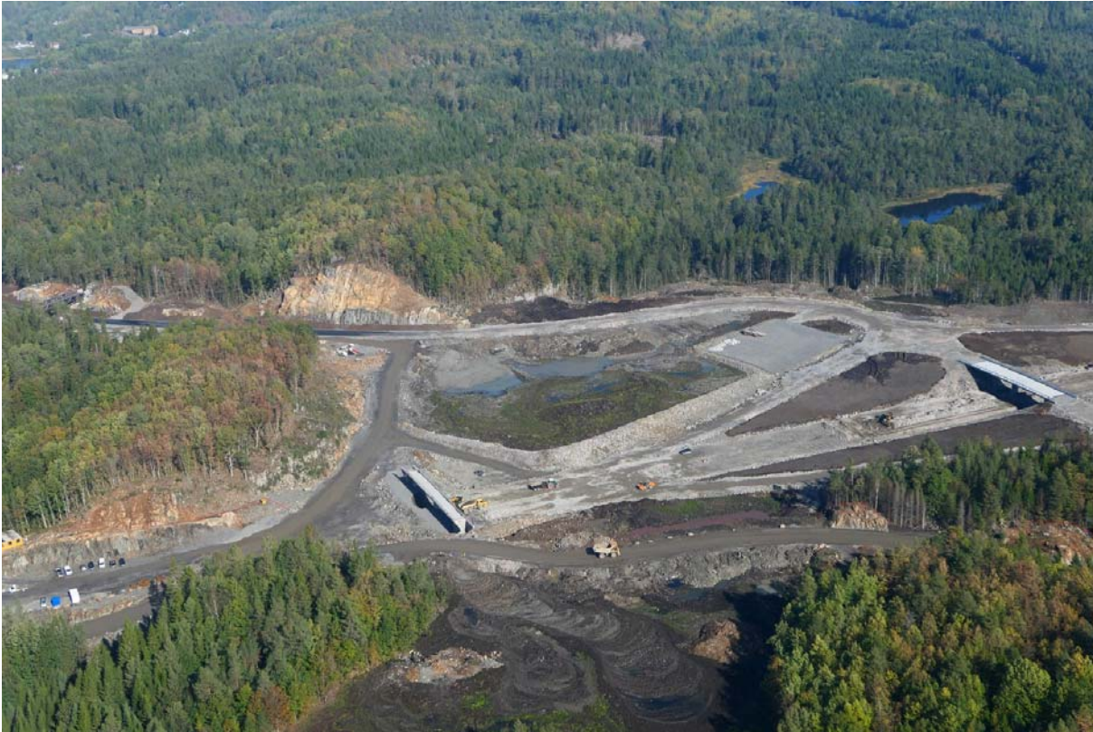
Figur 27. Moderne vegutbygging er arealkrevende. Bildet viser anleggsfase. Her fra parsellen E18 Tvedestrand-Arendal. Foto tatt under helikopterbefaring 18.09.2018.
