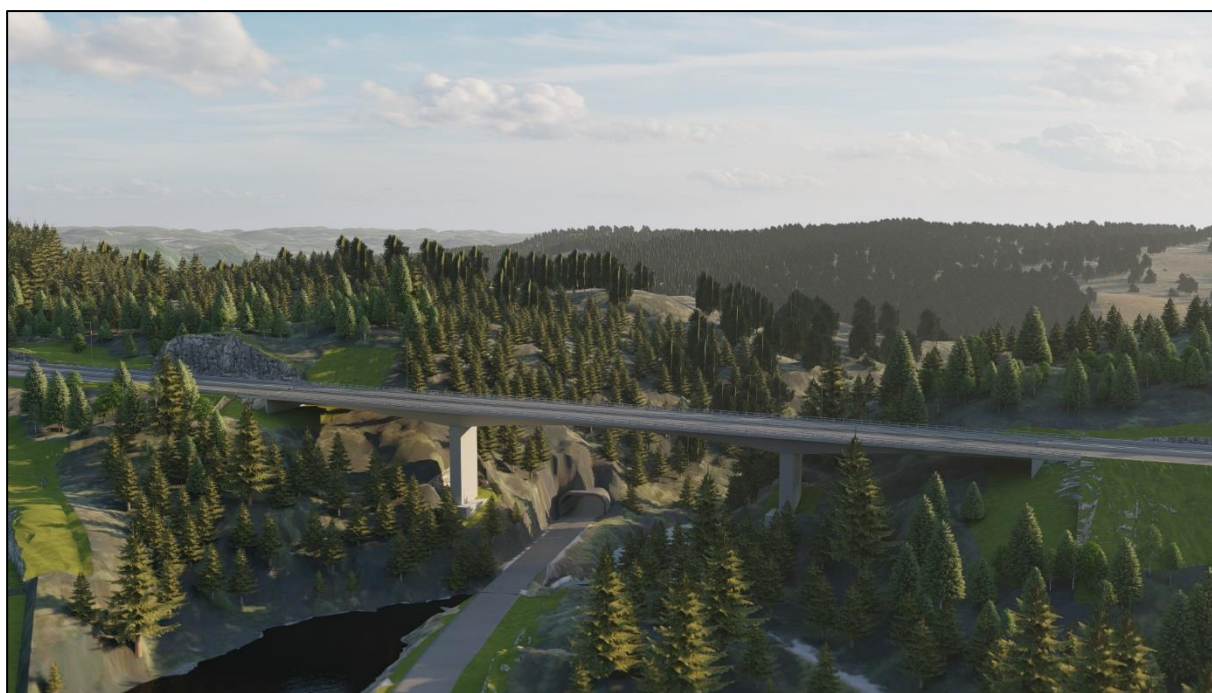
Figur 3-18 K100 Røyskår bru sett fra nord.
