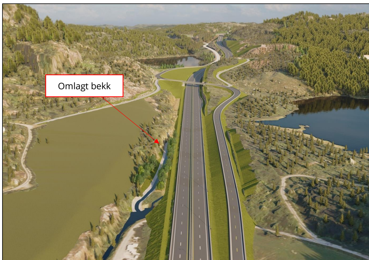
Figur 3-28 Bekkeomlegging fra Ytre Tjomslandsvann mot Steggjevannet (øvre del).
