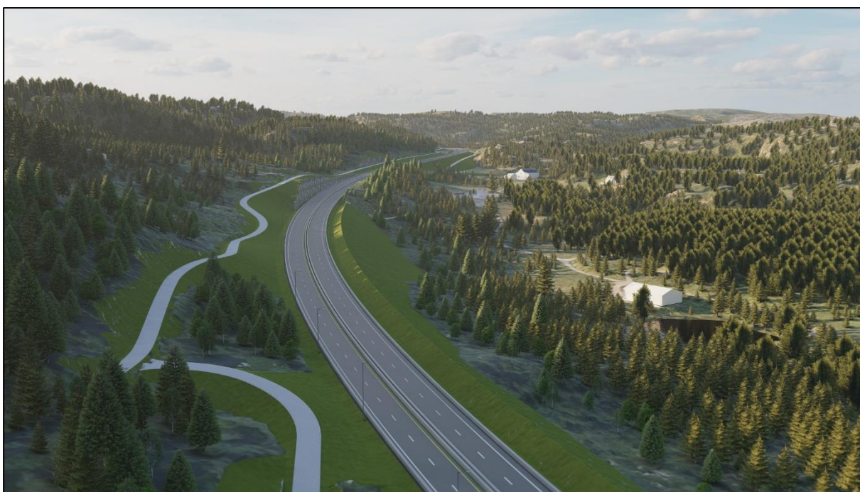
Figur 3-7 Støyskjermende voller langs ny E39.
