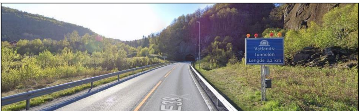
Figur 2-7 Vatlandstunnelen ved Rørdal. (Kilde: Google Maps)
