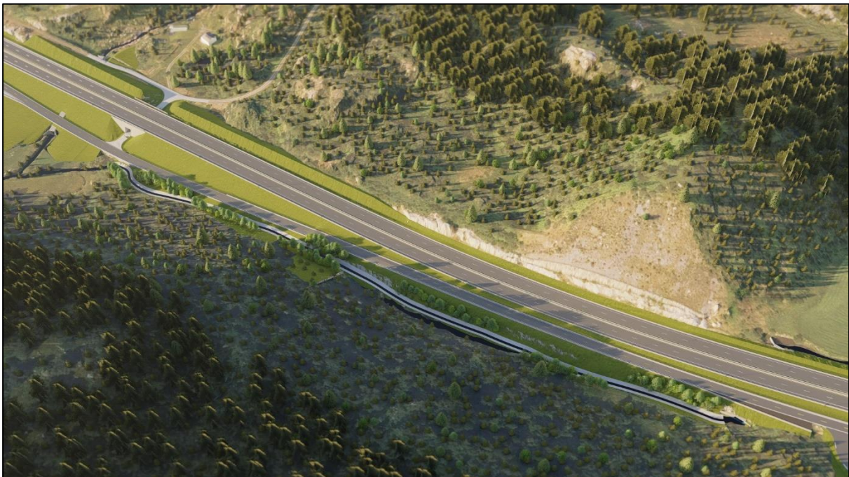
Figur 3-14 Omlagging av Tjomslandsbekken langs Dragedalen.
