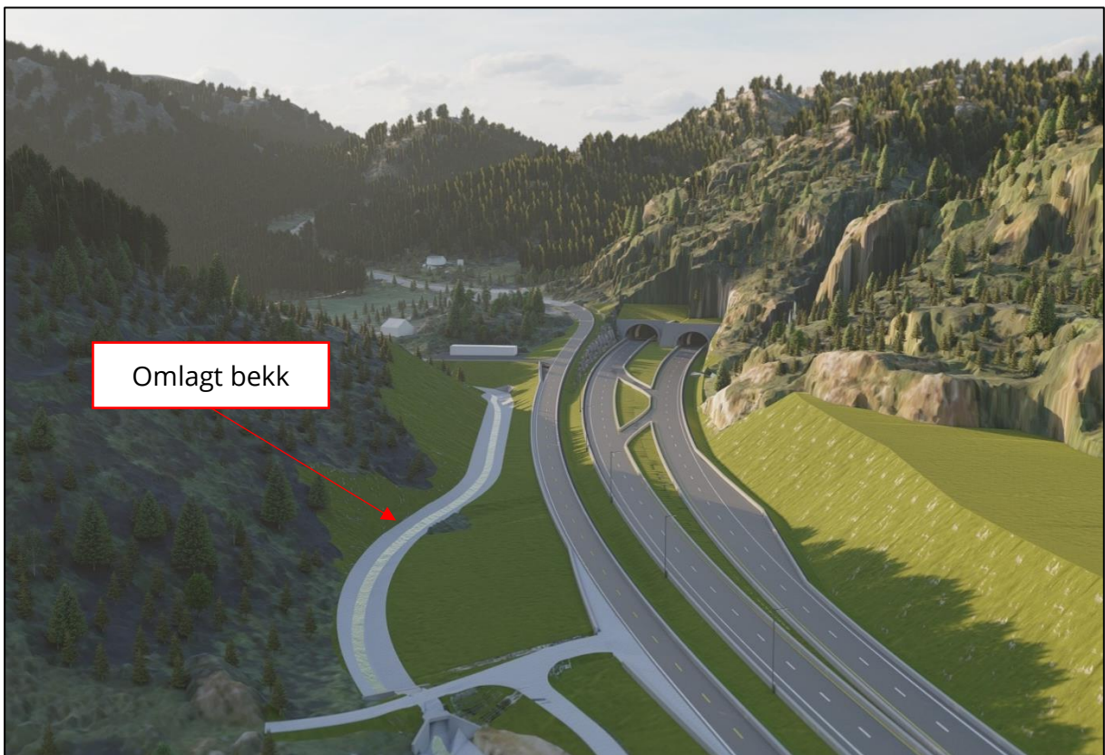
Figur 3-30 Bekkeomlegging fra Vatlandstunnelen mot Steggjevannet.
