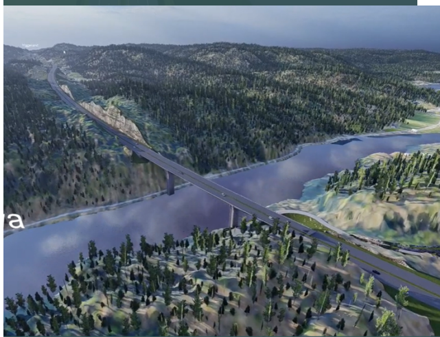
Parti ved Grundelandsvannet (Kilde: Nye Veier A/S) Bro over Mandalselva (Kilde: Nye Veier A/S)
