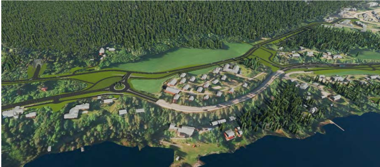
Figur 4-12 Illustrasjon av tiltak på eksisterende Holeveien og lokalvegnett sør for Sundvollen, sett mot sørøst fra Kroksund. Deler Holeveien bygges om, og det etableres nytt gang- og sykkelvegssystem med planskilte kryssinger av Holeveien og ny atkomstveg til Klokkerbråtan. Enkelte direkteavkjørsler til E16 saneres. Fra rundkjøring går det samleveg opp til ny atkomstveg til Klokkerbråtan, og atkomstveg til atkomsttunnel for jernbanetunnel Jong/Sundvollen. Planlagte løsninger tilrettelegger for eventuell senere utvikling på oversiden av dagens E16 i området.
