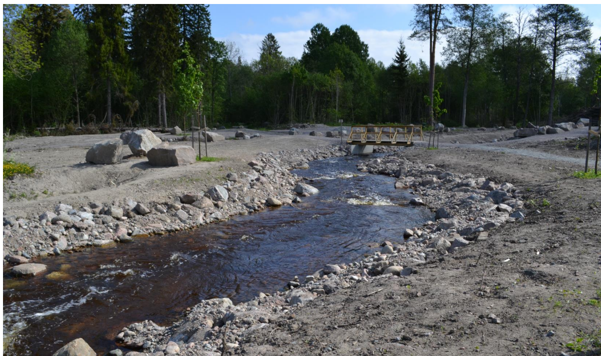
Figur 6-11. Eksempelbilde fra Storådammen, omlöp som viser hvordan elveleiet over fyllingen kan bli seende ut (foto: Axel Emanuellsson, Norconsult Sverige).
