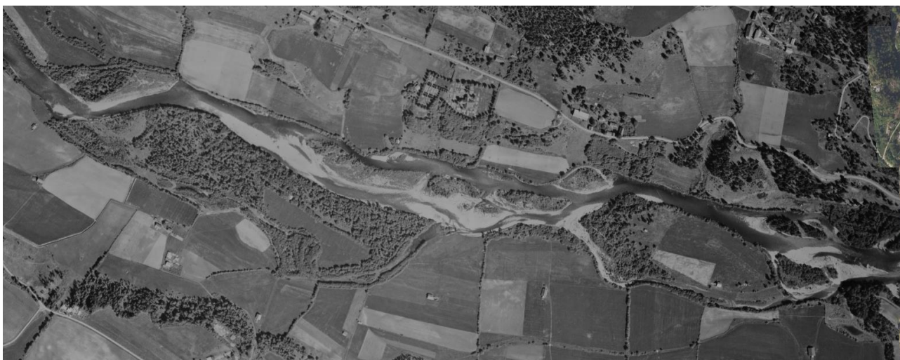
Figur 2-1. Nedre deler av Gausa i 1947, før kanaliseringen for tømmerfløting (Foto: Norge i bilder).
