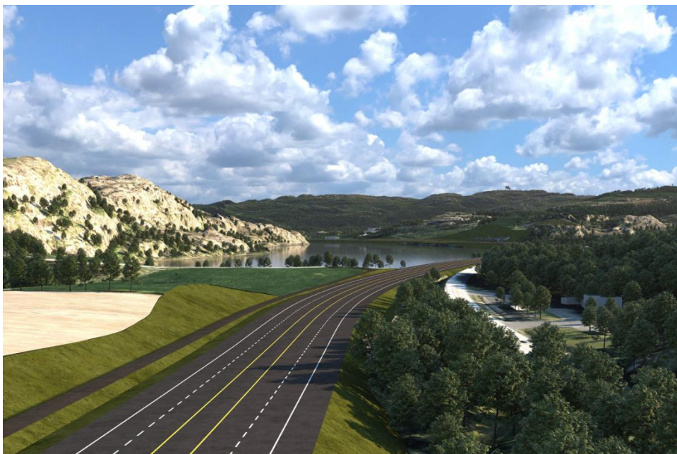
Figur 3-12: Trasé ved Søylandskiosken sett sørover. Omlagt adkomstveg til venstre. Ytra Kydlandsvatnet i bakgrunnen
