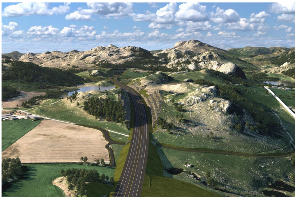
Figur 3-15: Trasé sett nordover fra Solheim. Kulvert for lokalvei gjennom fylling for E39
