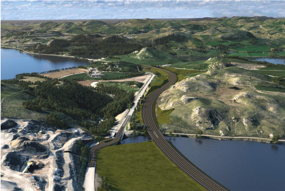
Figur 3-20: Trasé ved nordre del av Skurve og Klugsvatnet sett nordover. Bollestadkrysset i bakgrunnen
