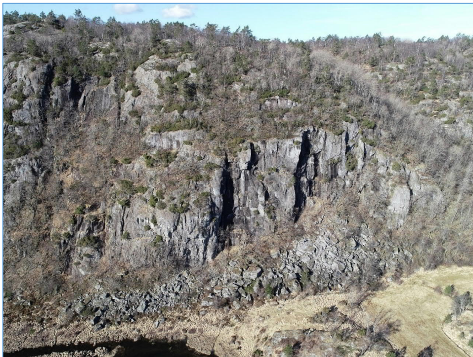
Figur 26: Dronefoto av østlig påhuggsvegg.
