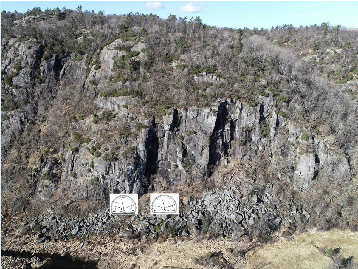
Figur 10: Dronefoto av østlig påhuggsvegg med omtrentlig påhuggsplassering.
