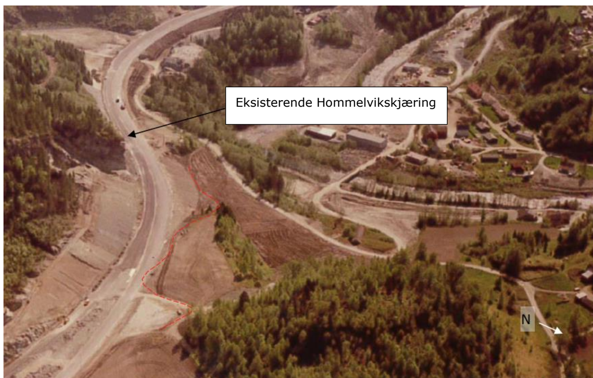
Figur 34: Foto fra byggetiden av eksisterende E6. Rød linje er referanselinje til Figur 33. Kilde: Rambøll arkiv.
