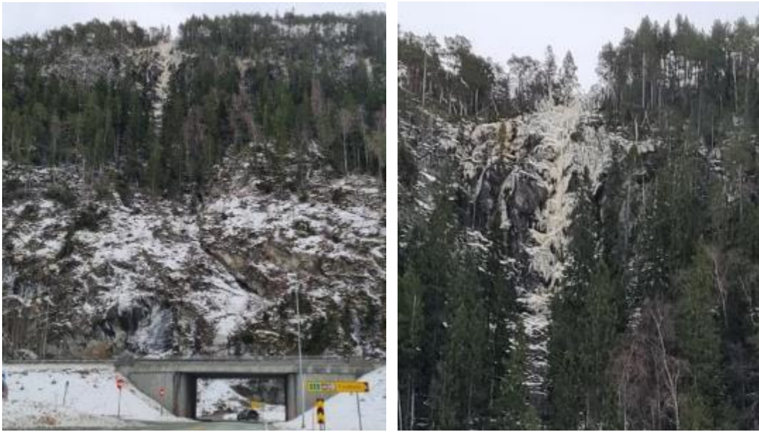
Figur 13: Bilde av isdannelse over Hommelvikkrysset og pendlerparkering. Dato: 3. oktober 2021.
