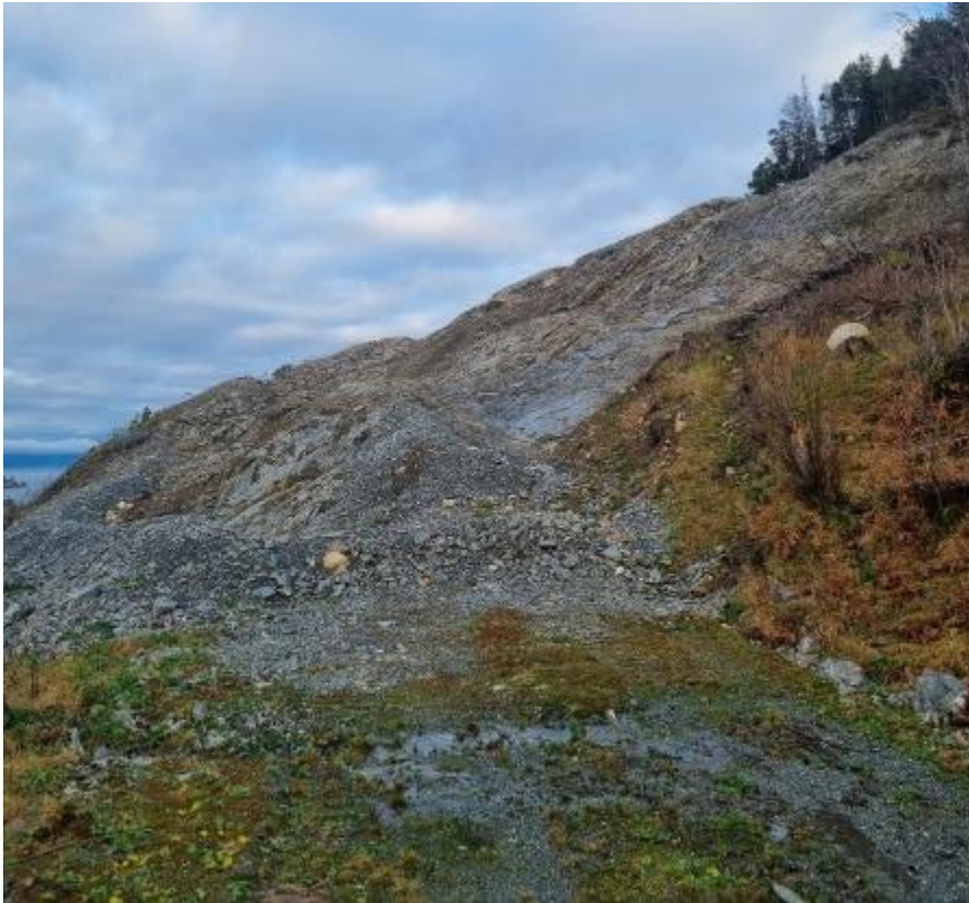
Figur 22: Avrensket område over eksisterende høye berskjæring, profilnr. 16050-16130. I tidligere anleggsfase er det etablert en midlertidig voll for å beskytte eksisterende E6 under renskearbeidet.
