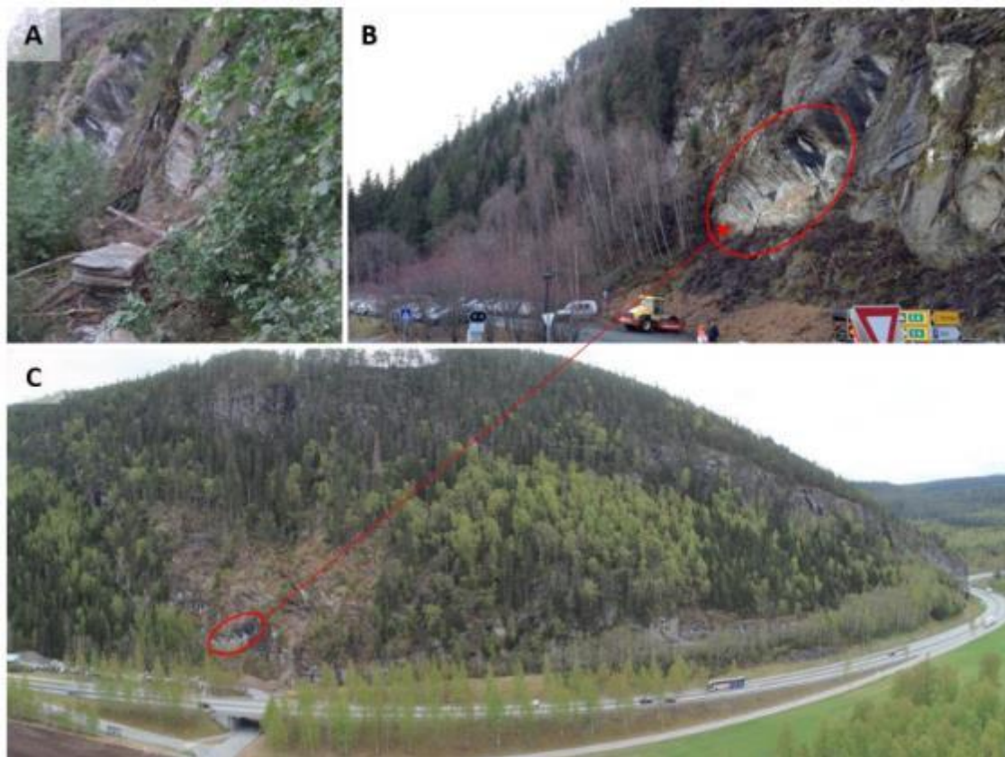
Figur 18. Bilder fra Statens vegvesen, hentet fra tidligere reguleringsplanrapport (Multiconsult & Acciona, 2019) . Viser steinspranget ved pendlerparkeringen 23.september 2012. A viser området før opprydning, B viser området etter opprydning, og C viser er oversiktfoto over løsneområdet.
