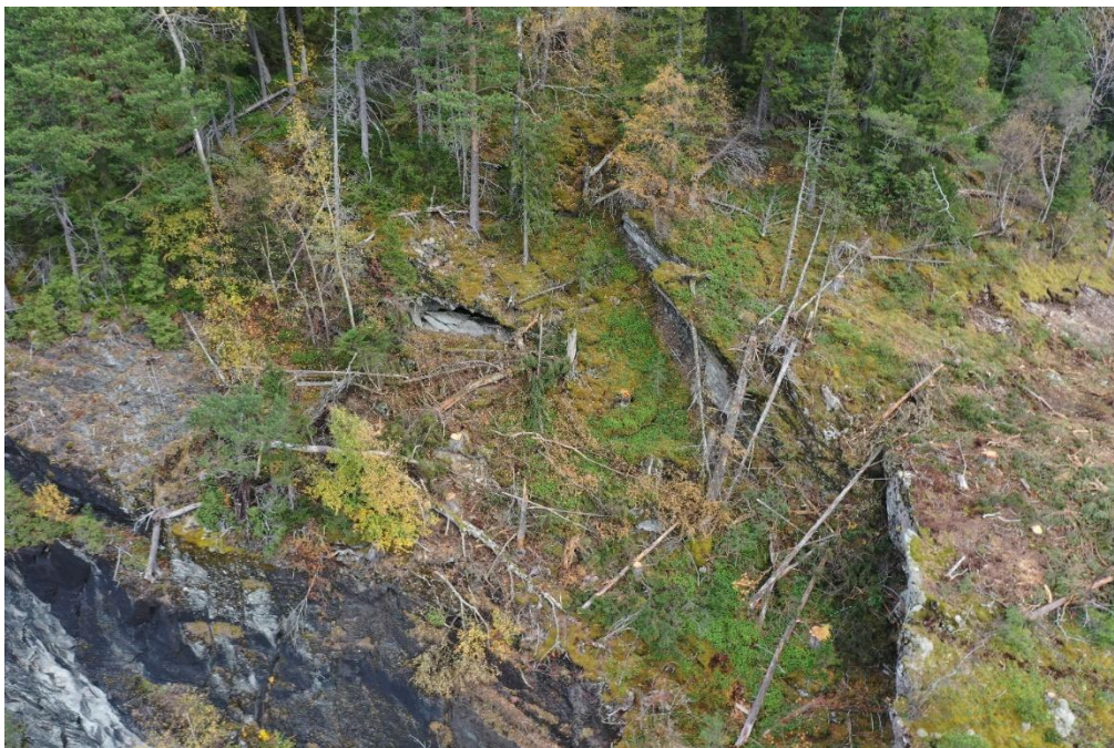
Figur 12: Hjørnet rett nord for eksisterende høye bergskjæring.
