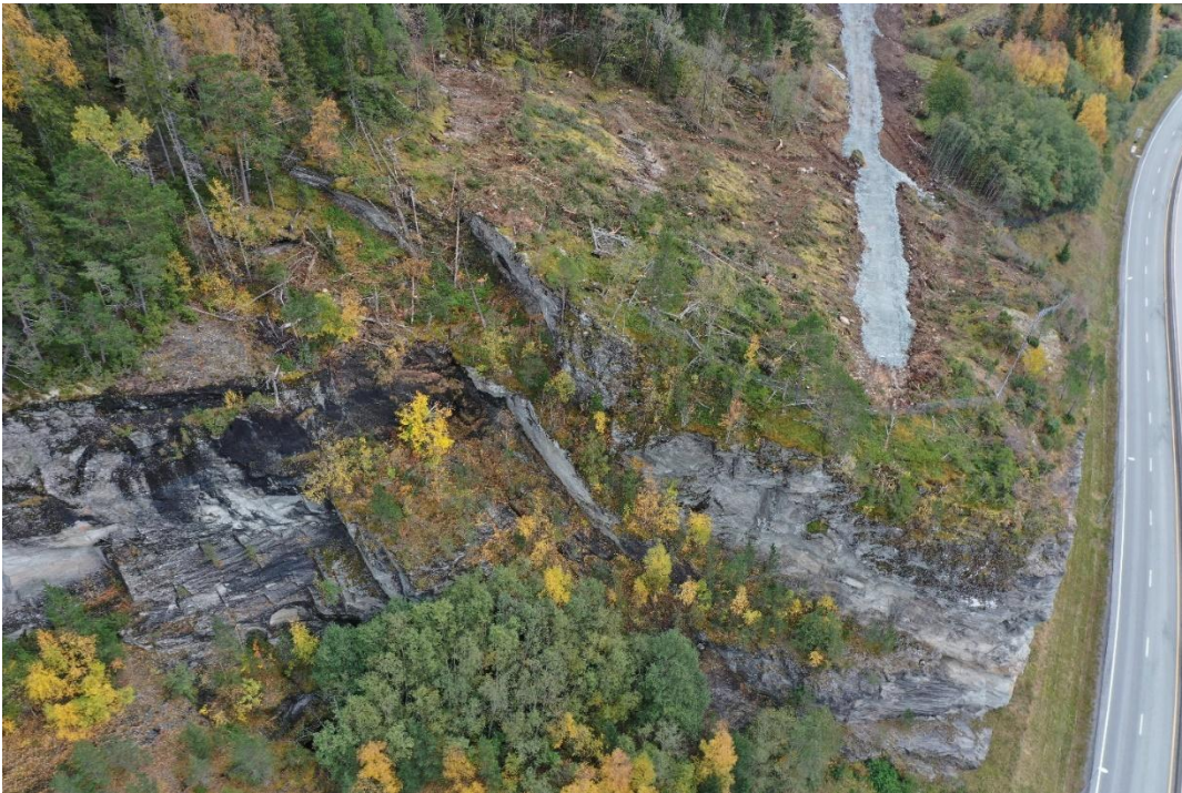
Figur 9: Terrenget nord for eksisterende høye bergskjæring før området ble rensket.
