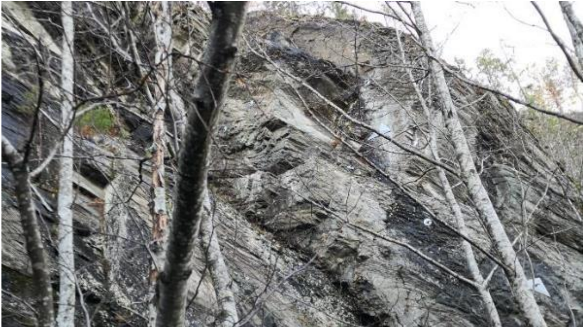
Figur 21: Spredt bergsikring i klippeområdet rett nord for eksisterende høye bergskjæring, ca. profilnr. 16160.
