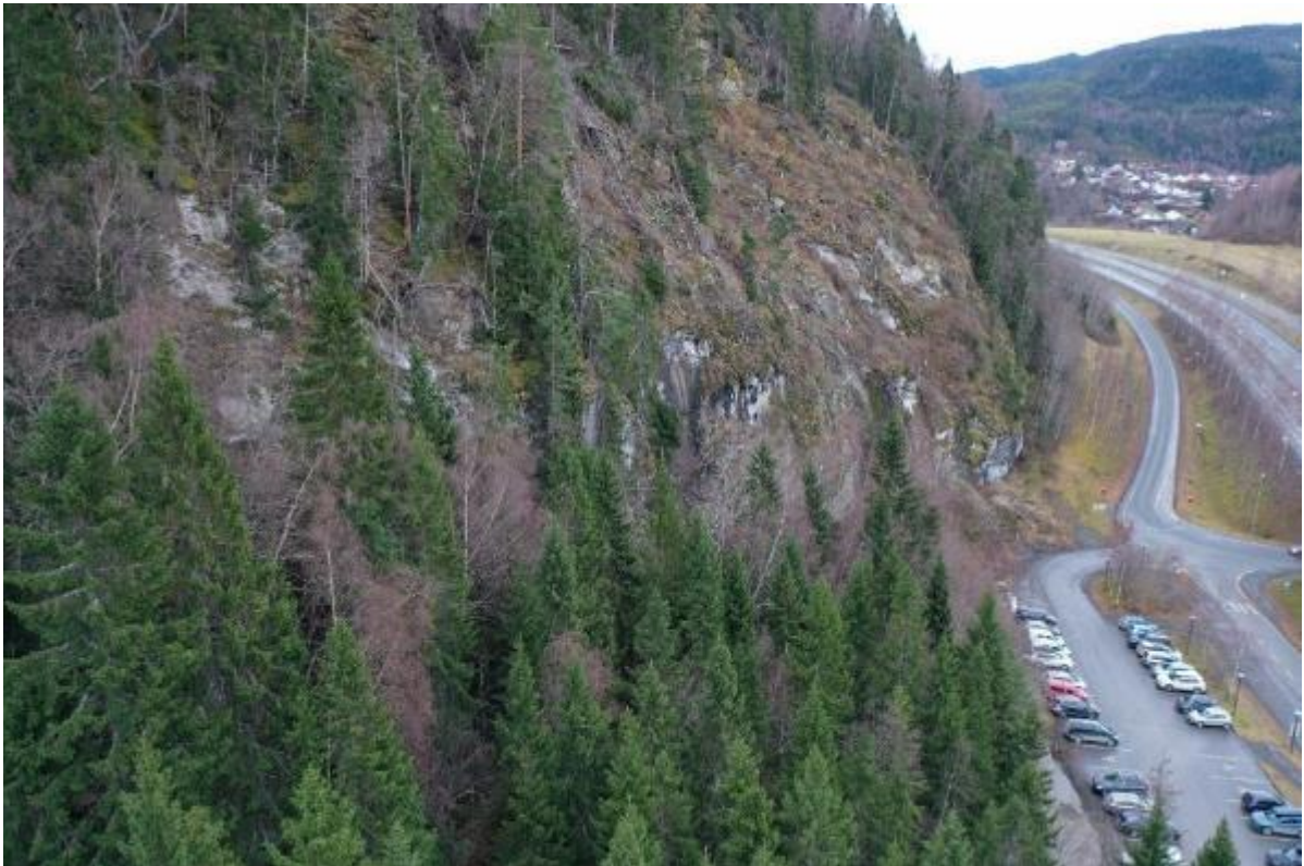
Figur 28: Dronefoto av nedre del av terrenget over pendlerparkeringen og Hommelvikkrysset.
