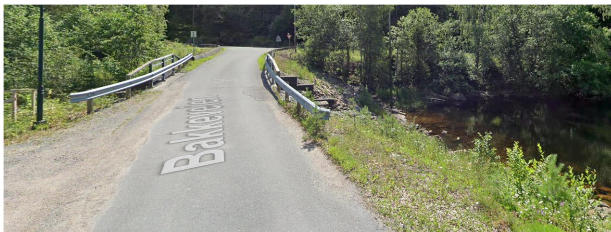
Figur 6-37 Eksisterende bru over Gongelva, sidevei nederst.
