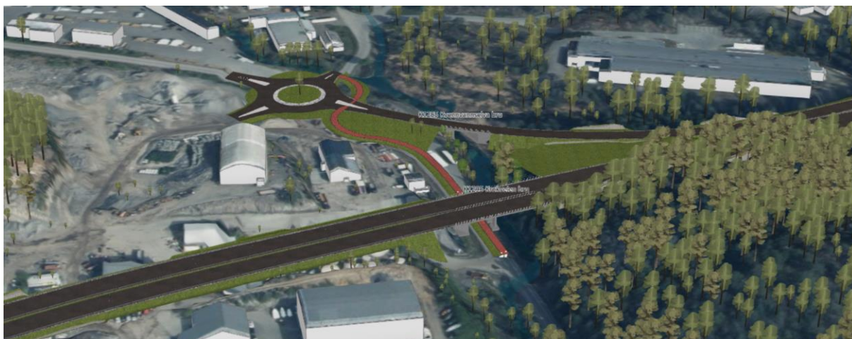
Figur 6-1 Kvennvannselva og Krokenveien bru.
