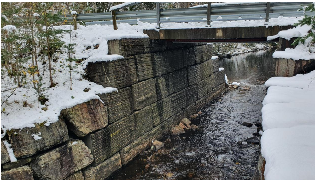
Figur 6-38 Forbygning oppstrøms eksisterende bru over Gongelva.
