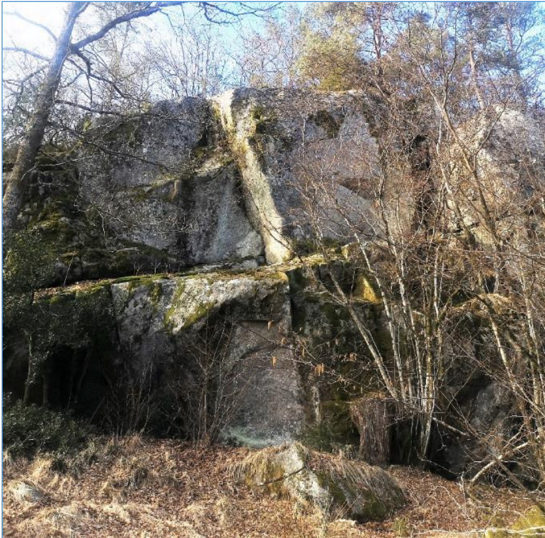
Figur 100: Blotning hvor sprekkeorienteringen til de tre hovedsprekkesettene er tydelige. Berget er massiv granitt, med utholdende sprekker.
