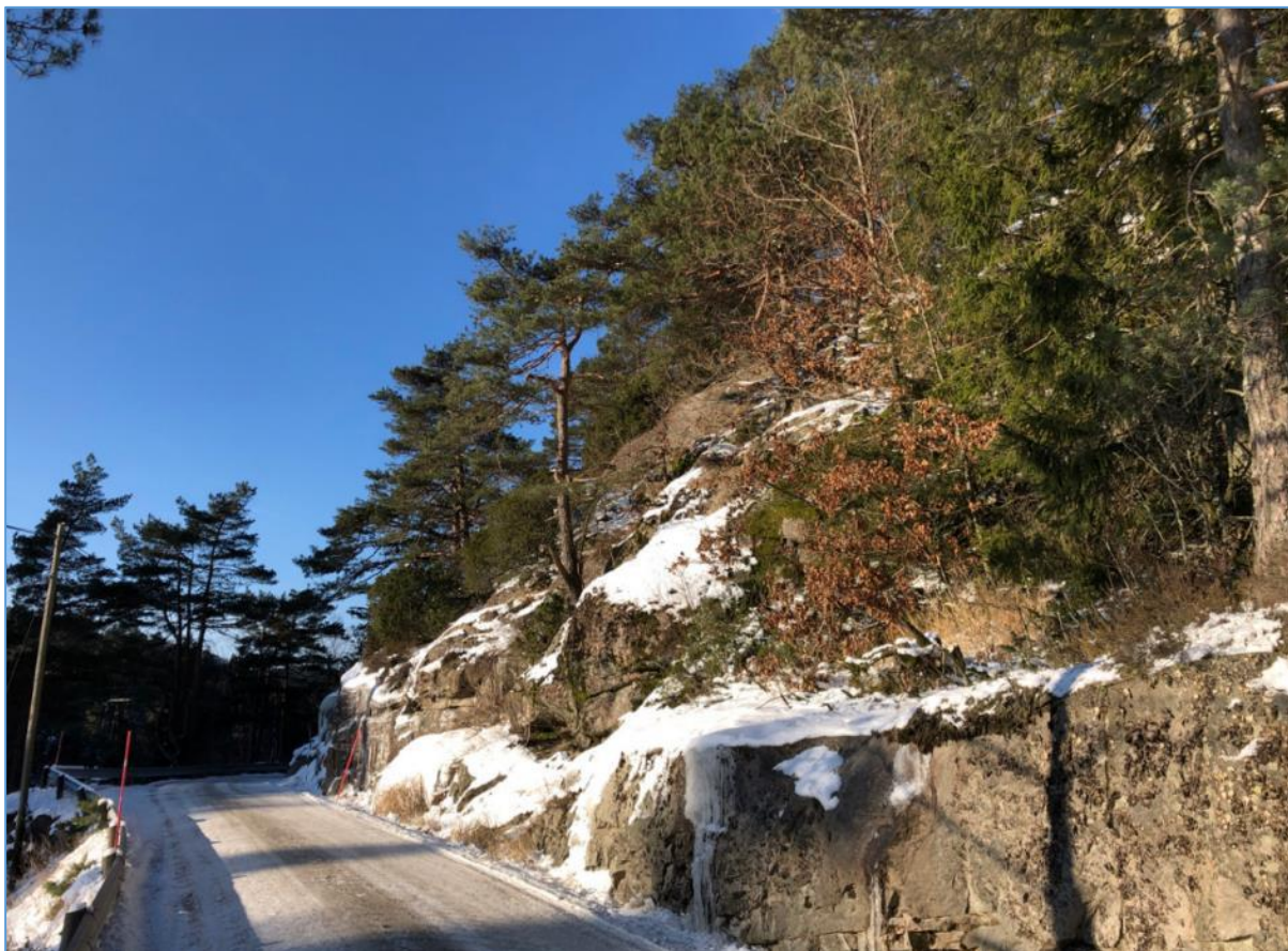
Figur 89: Dagens Sjølingstadvei med sideterreng. Bilde tatt ca. profil 1100 mot vest.
