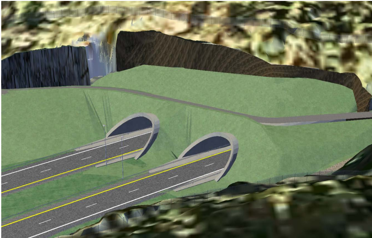
Figur 40 Nye portaler for Homledaltunnelen ved Skaret
