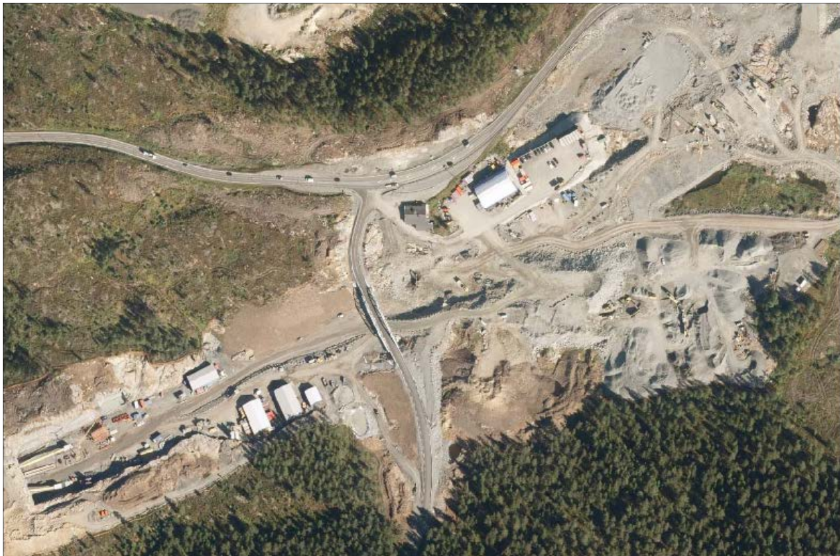
Figur 56 Riggområde for tunneldriving, E134 ved Kongsberg (Kilde: www.norgebilder.no )
