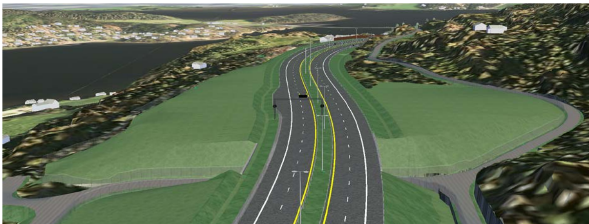
Figur 33 Terrengforming med overskuddsmasser ved Øverby
