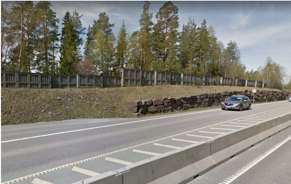
Figur 17 Eksisterende støyskjermer på E16 ved Jotaveien (foto Google maps)
