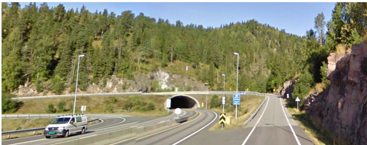
Figur 24 Dagens situasjon ved Skarettunnelen sør (foto Google maps)
