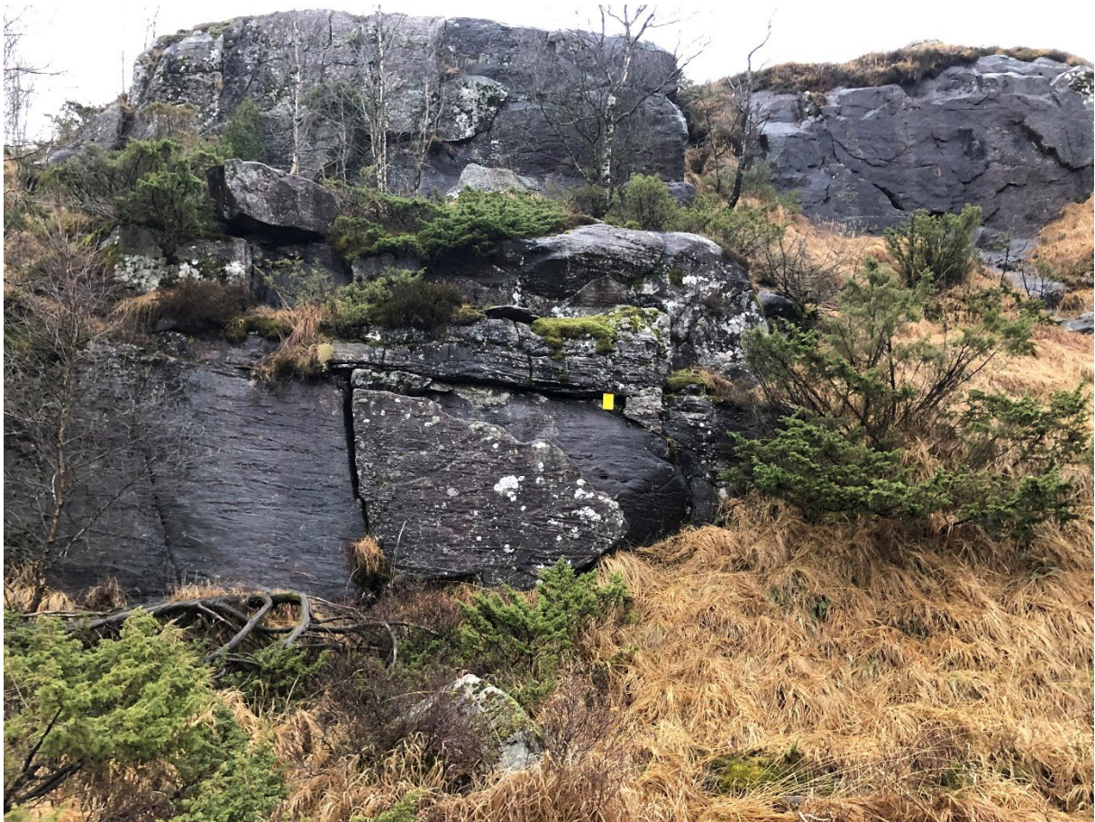
Figur 6-16. Bergblotning ved skjæring 7200, bilde av bergvegg/østre kant av skjæringen. Bildet er tatt mot øst ved lokalitet «M Skjæring 5 Lok 2»
