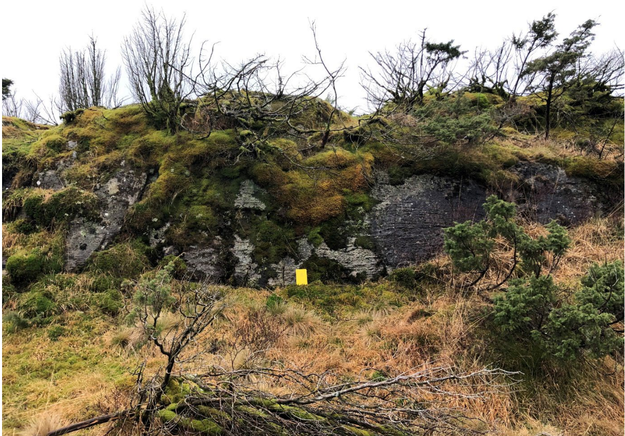
Figur 6-13: Befaringsbilde fra skjæring 6650. Bildet er tatt mot vest ved lokalitet «M skjæring 4 lok 1».
